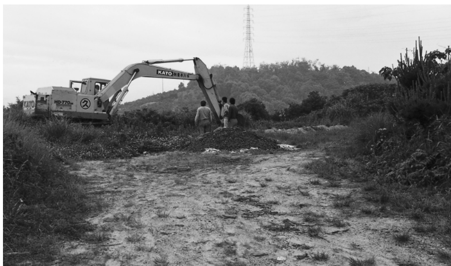
3. 掘削風景 (北より)
