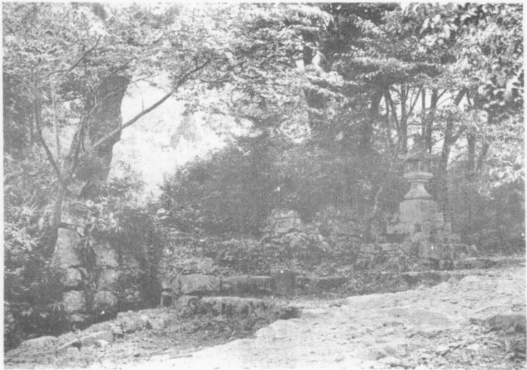
義 俊 坊 舊 宅 址
