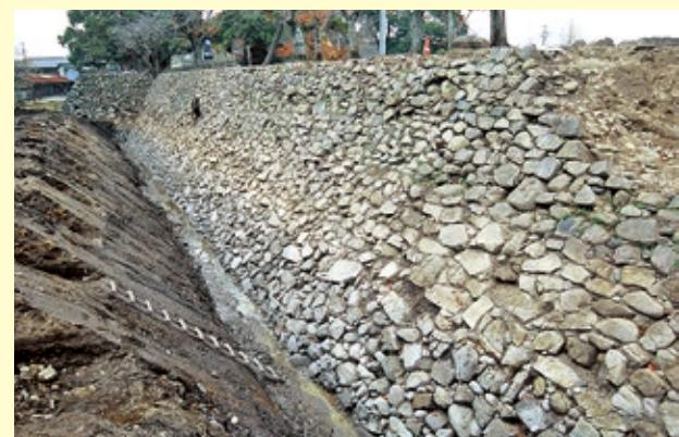
石垣は「反り」がなく直線的ですが、両端より中央の方がより傾斜します。力を内側に集中させ、倒れにくくするためです。
