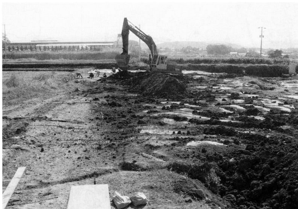
徳永川ノ上遺跡表土剥ぎとり作業
