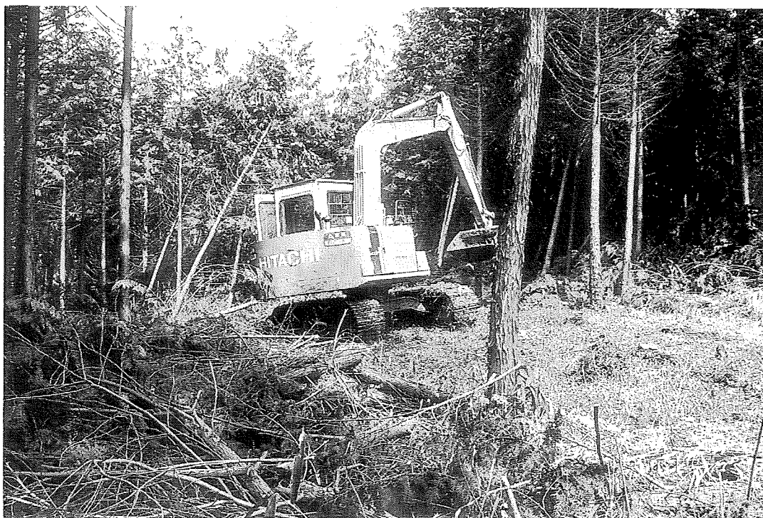
重機による表土剥ぎ
