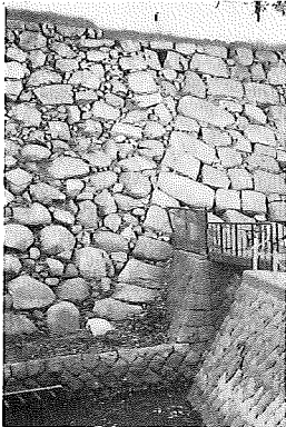
本丸石垣 黒田時代(右側)と細川時代(左側)の遺構が対比できる。
