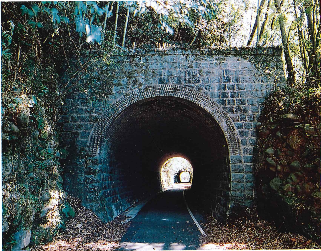
厚ヶ瀬トンネル
