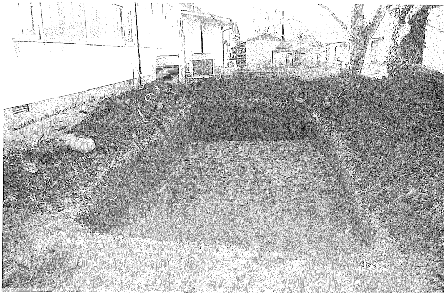
真坂地区 トレンチ調査状況
