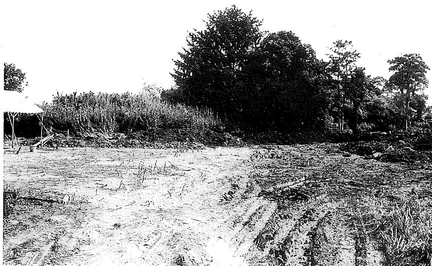
土田若林地区 調査前
