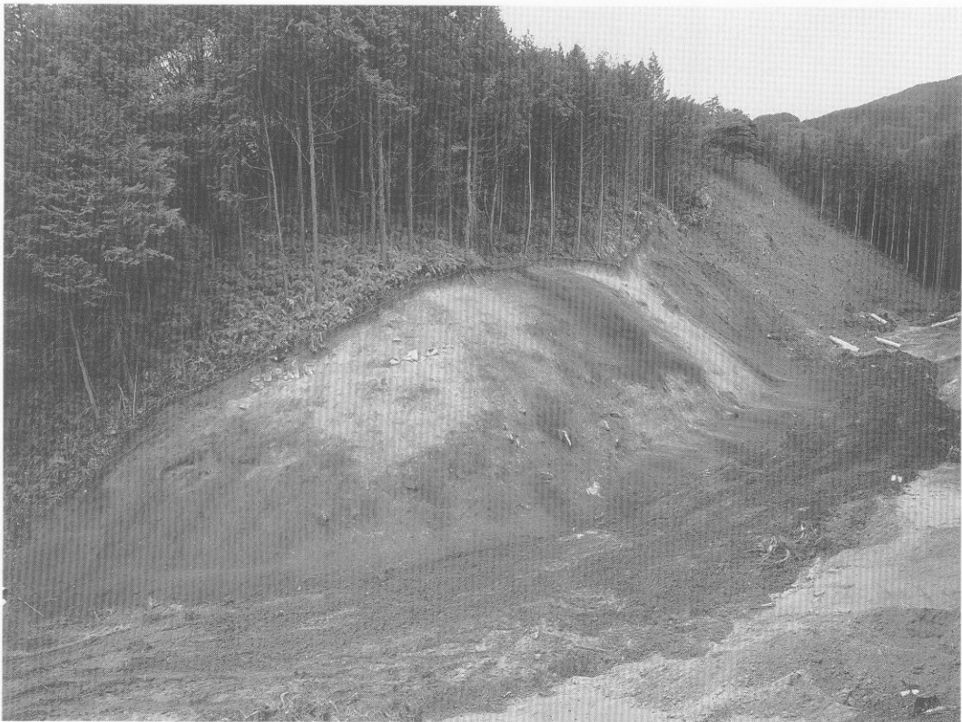
2. A-2 地区裾部確認調査状況 (北から)
