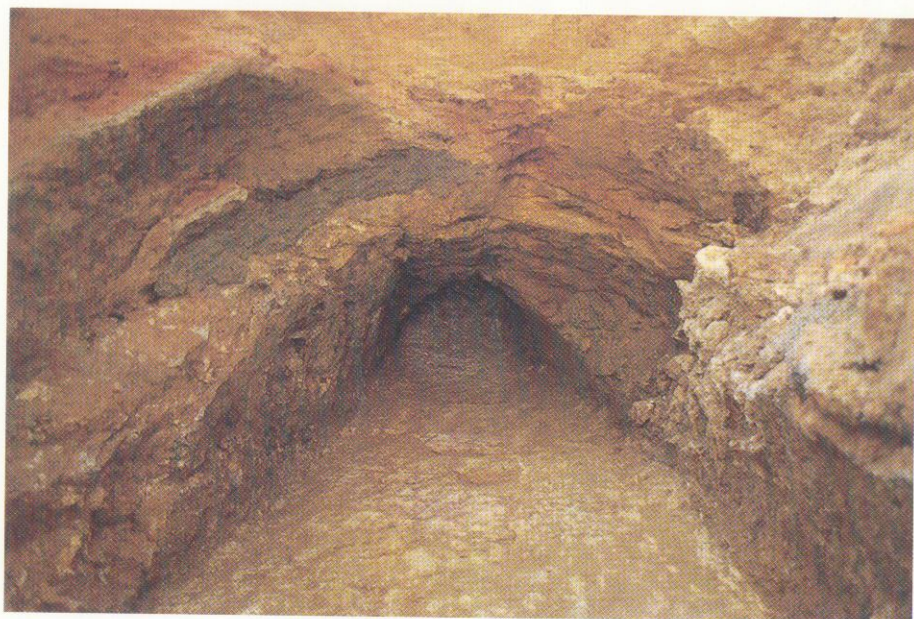
2. A-3地区 4号窯跡焼成部天井補修状態
