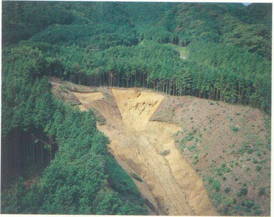
1. B-2地区 全景（北上空から）
