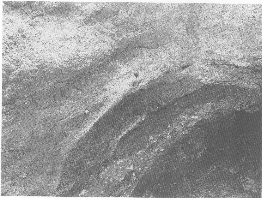
2. 4号窑天井部補修部分拡大
