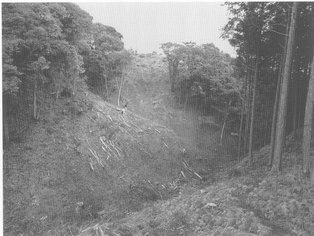
1. A-1地区伐採後全景（南から）
