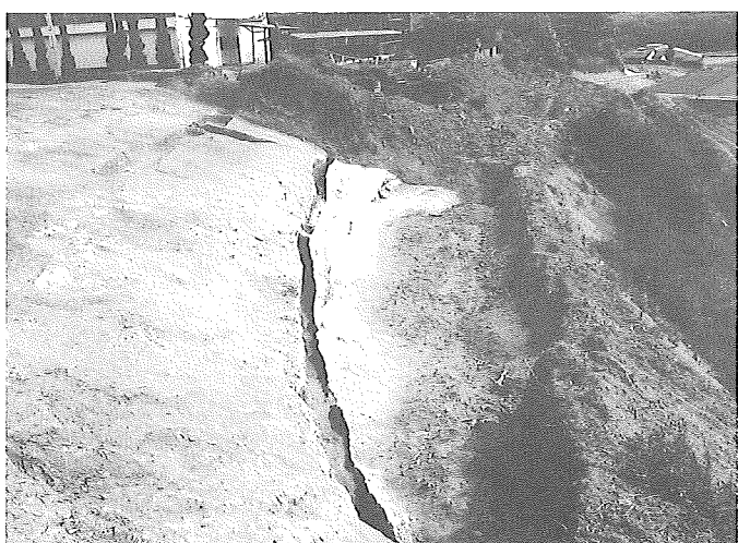
H 2 10号溝完掘状況
