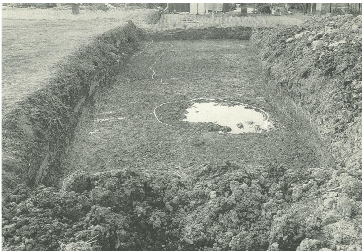
(2) 1-III トレンチ遺構検出状況
