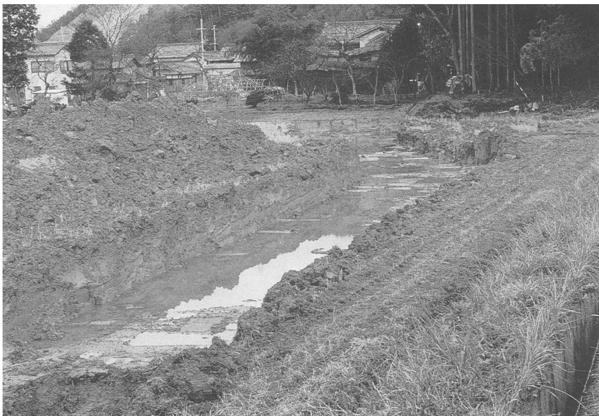
(2) 11 トレンチ完掘状況
