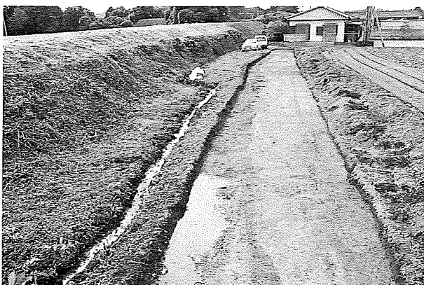
写真21 6区1トレンチ(東→西)
