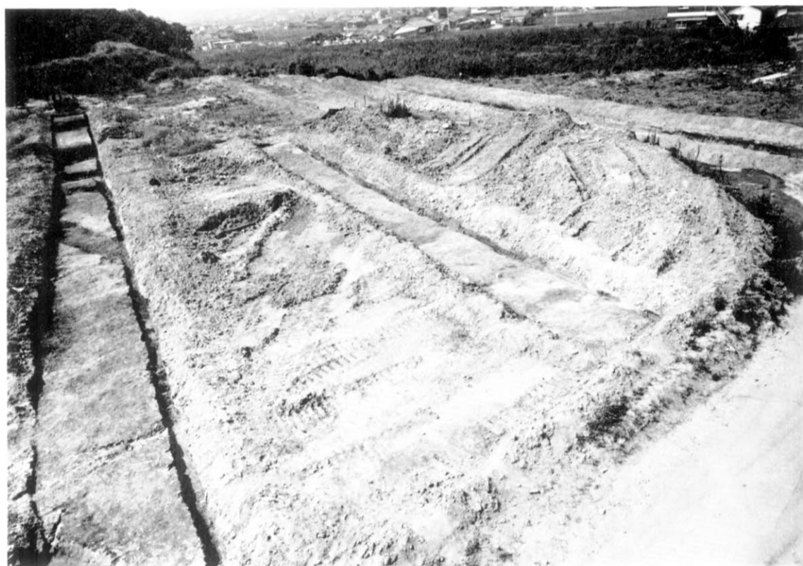
(2) O~R区 南半調査後の状況(北東より)
