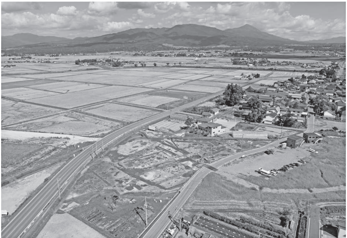
4 北区全景（1）（南西から）
