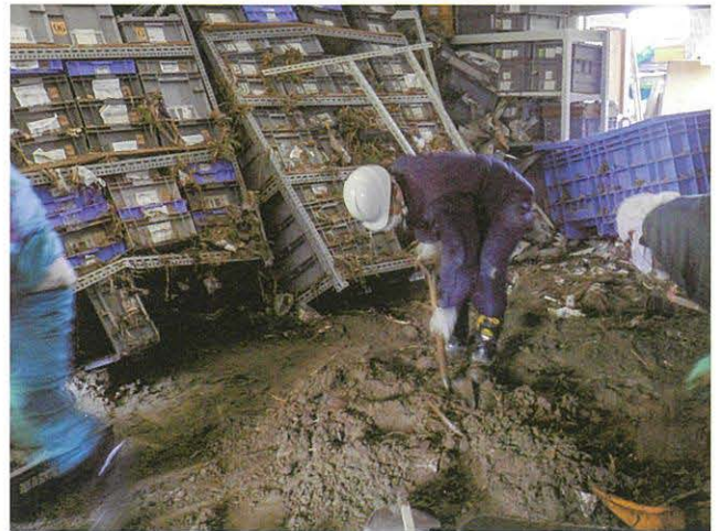
被災地での救出作業（平成23年4月21日 須賀川市）
