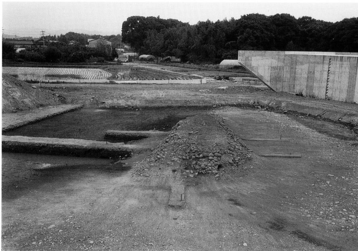
(1) 表土除去後（南東から）
