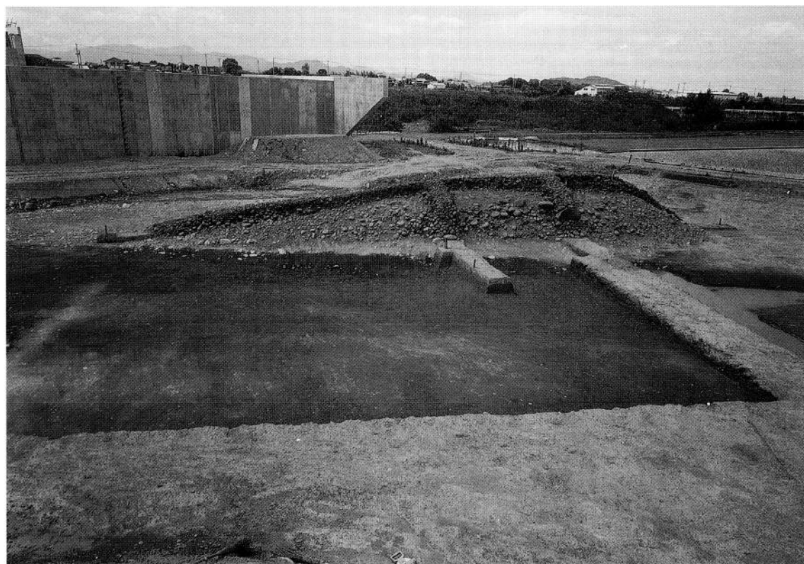
(2) 表土除去後 (南から)
