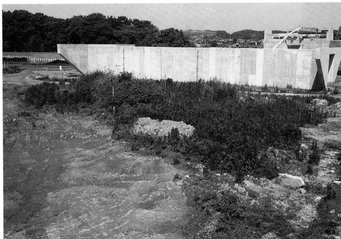
(2) 発掘調査前状況（東から）
