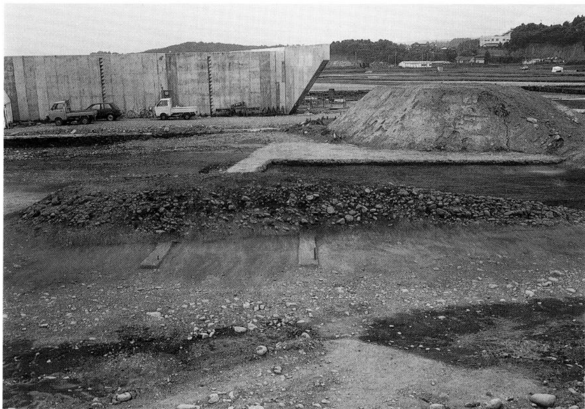
(2) 表土除去後（北から）
