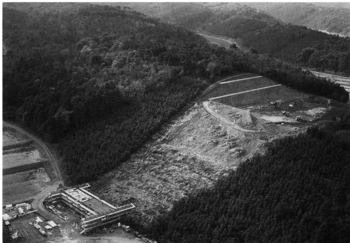
1. 椎田バイパス建設工事に入った石堂中後ヶ谷古墳群 (1988. 12. 19)
