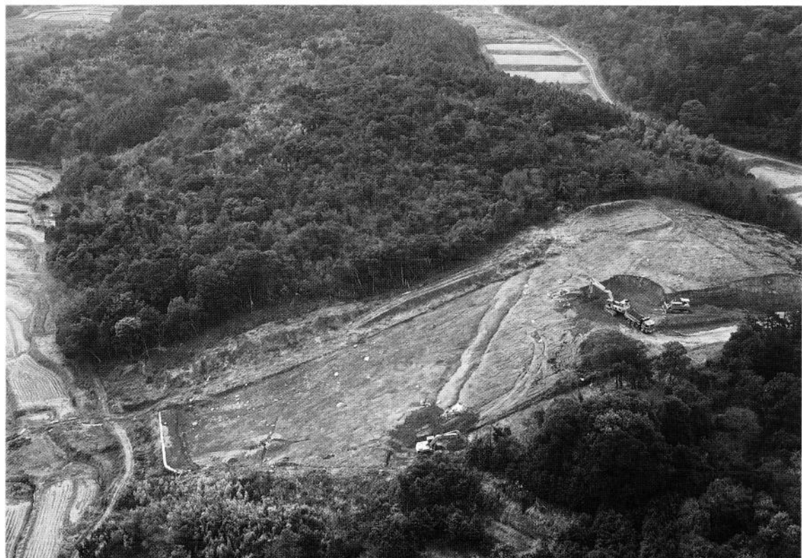
2. 椎田バイパス建設工事に入った菜切古墳群 (1988. 12. 19)
