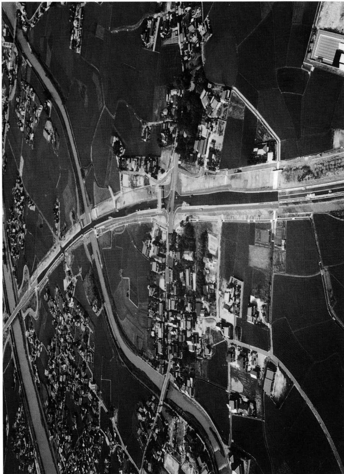
金屋遺跡付近 航空写真(南から) 建設省提供
