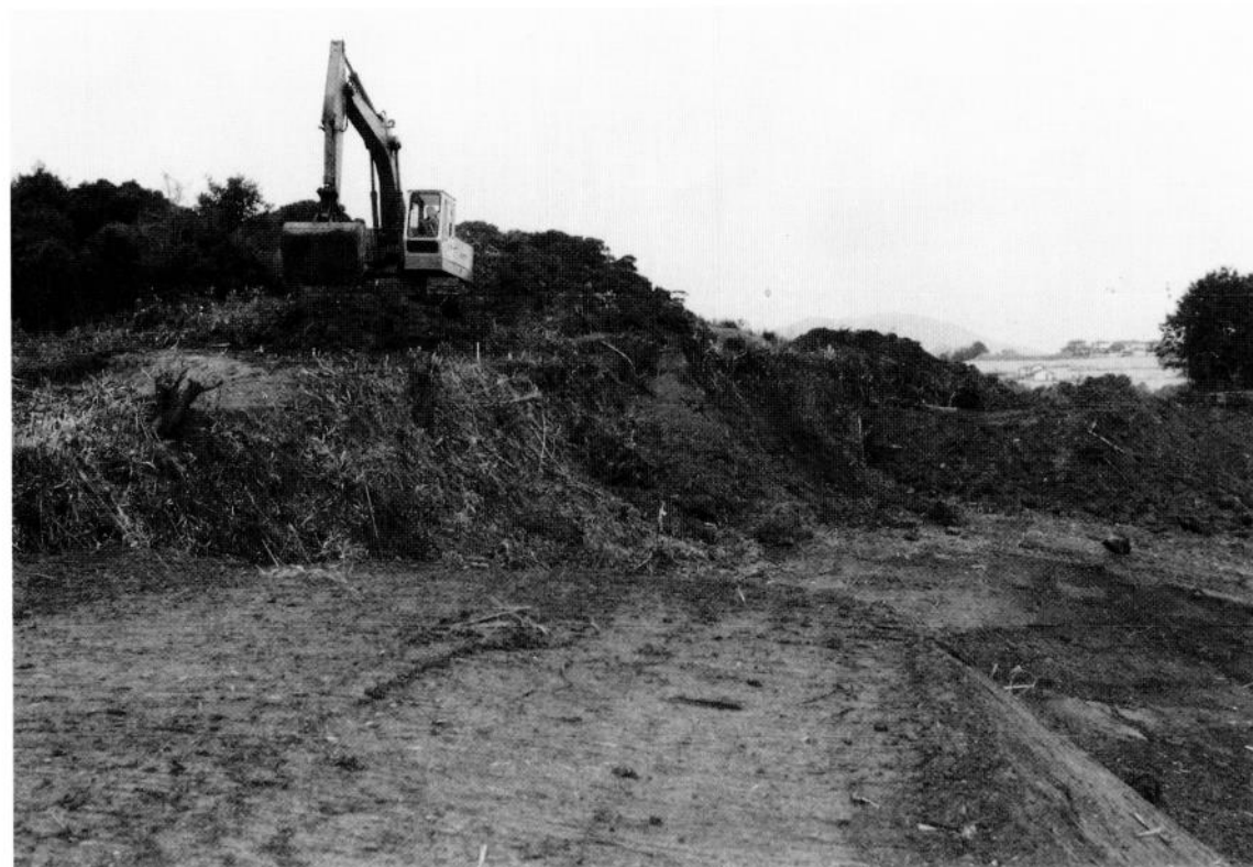
2. 同 西側の表土除去作業〔南東から〕
