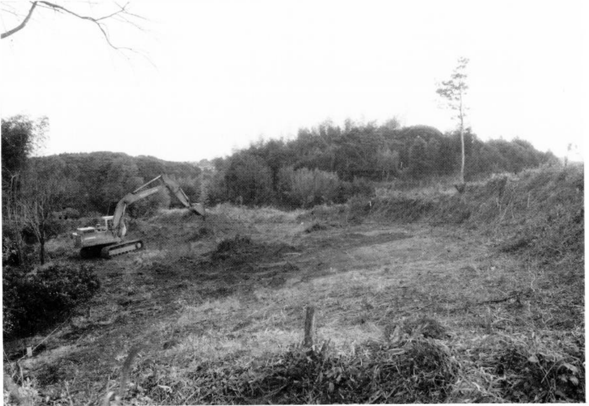
1. 山田沖古墳群中央区東側の表土除去作業〔北から〕
