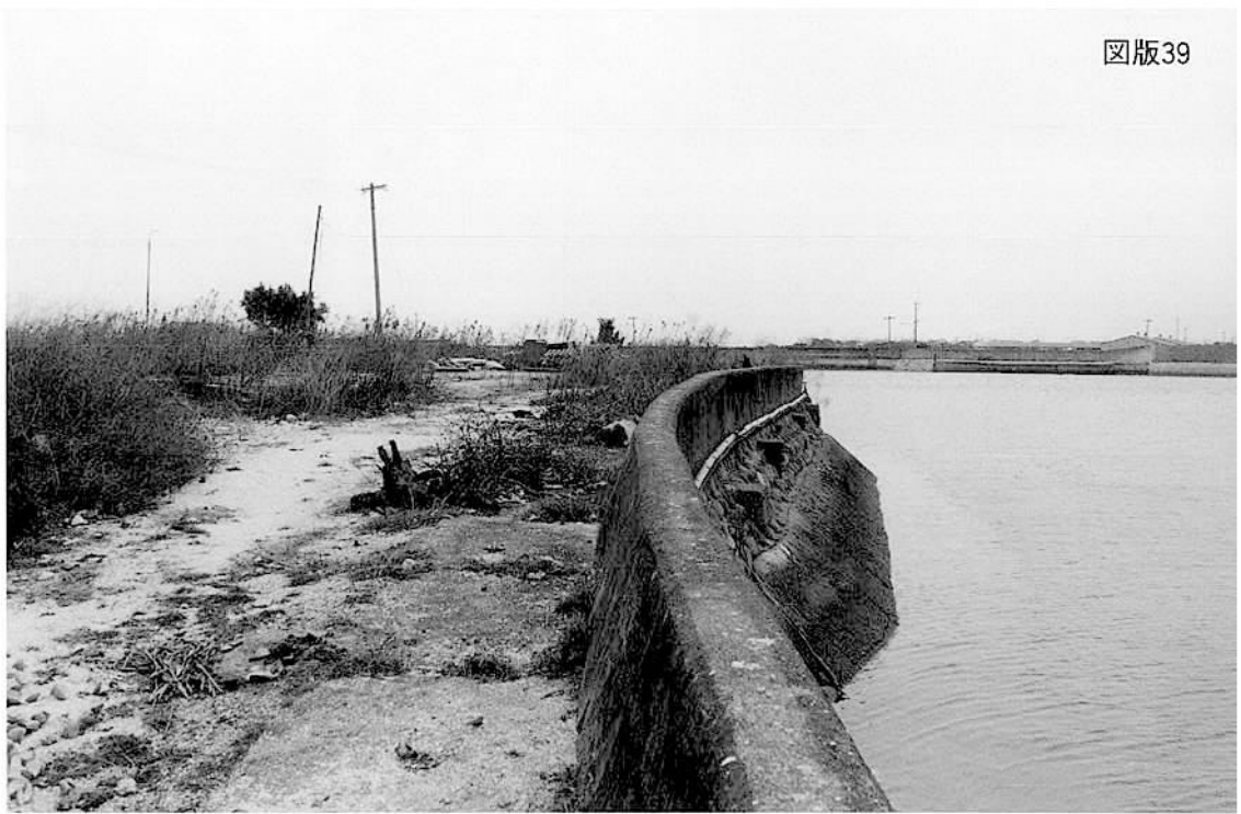
1 高浜番所跡 平成7年度調査地 遠景（西から）
