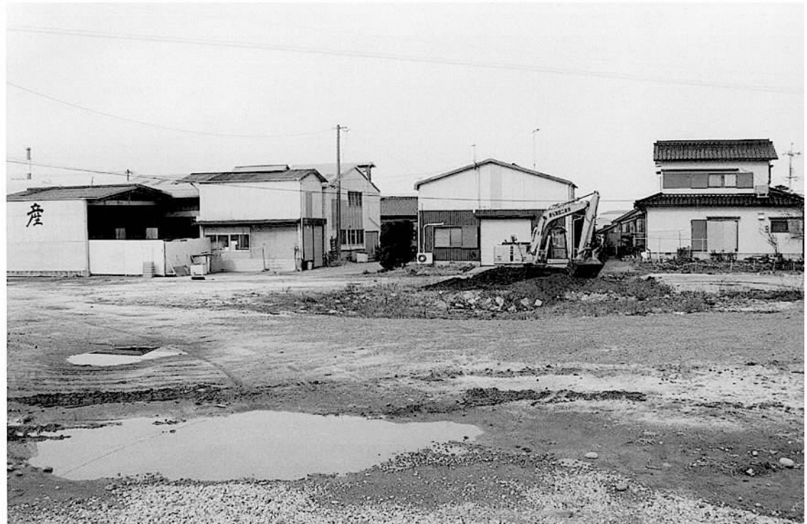
3 高浜番所跡 平成10年度調査地 掘削状況（西から）
