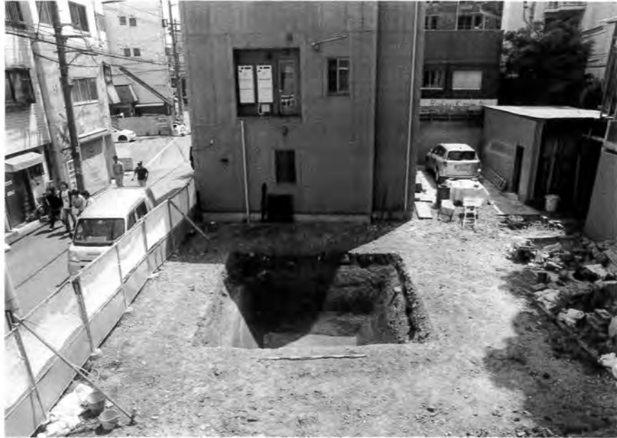
調査地全景 (北から)
