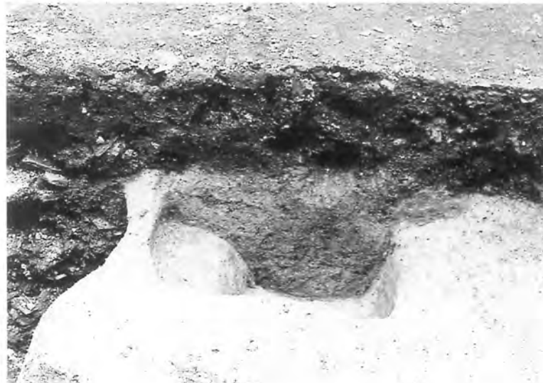
SK01完掘状況 (西から)
