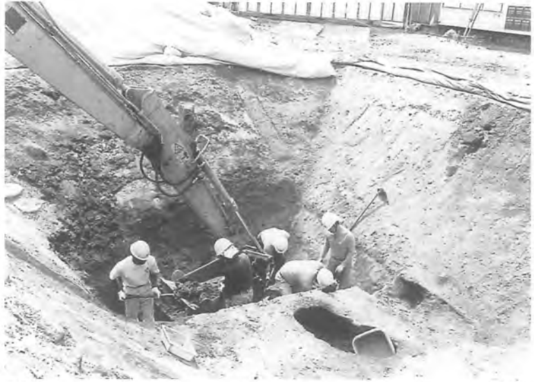
第3層掘削状況 (東から)
