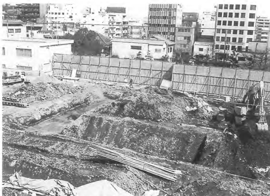
調査地遠景 (南西から)
