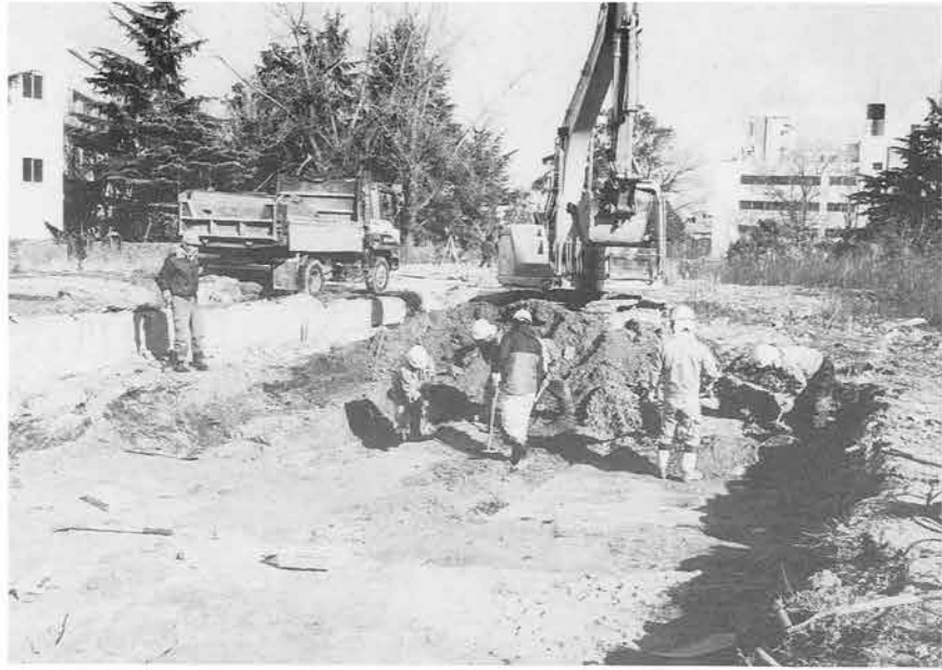
機械掘削時の風景 (西から)
