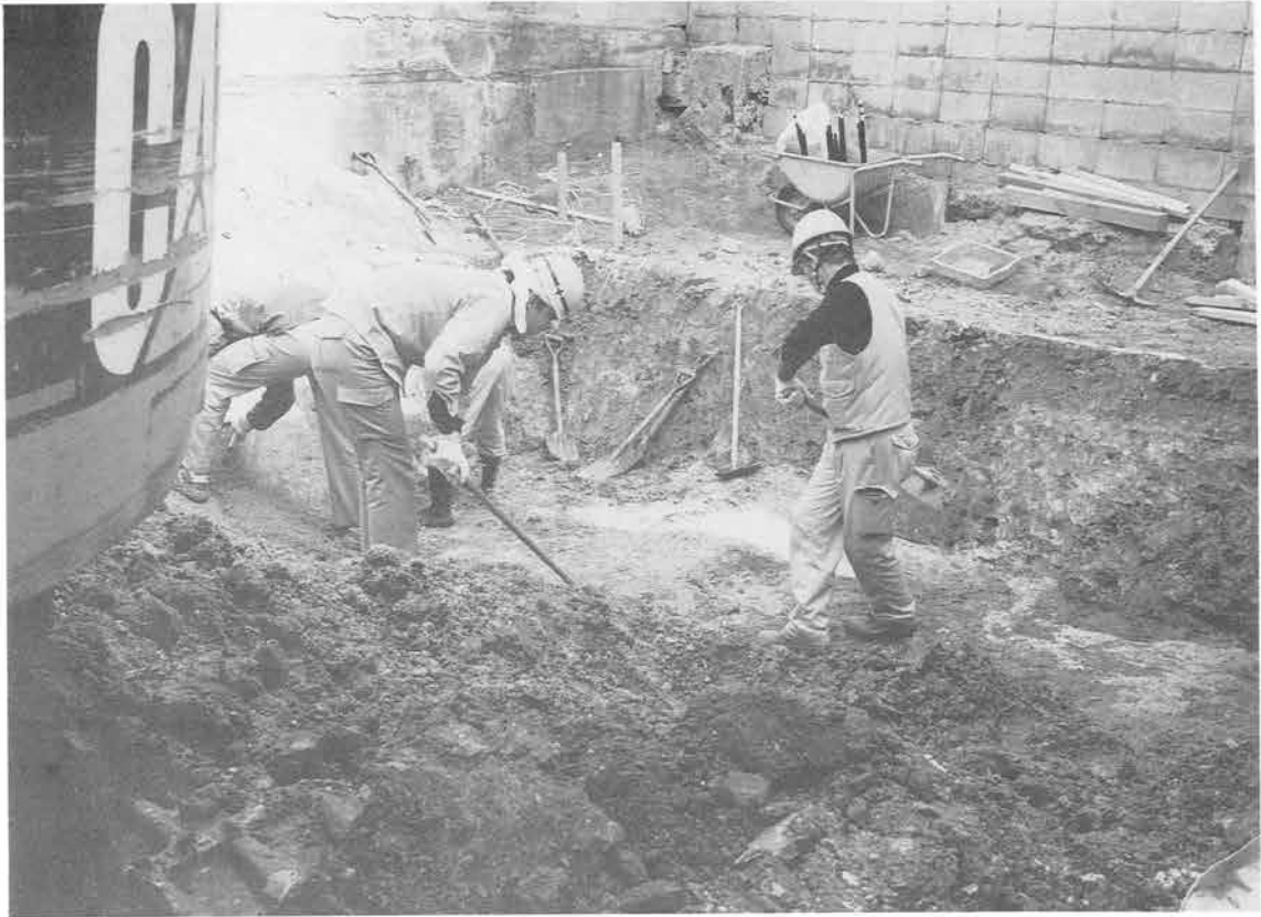
調査風景（機械掘削時）
