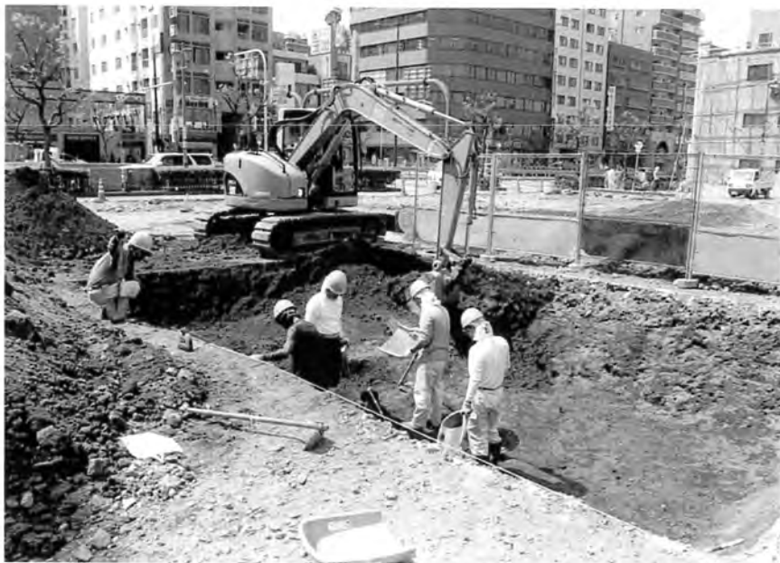
機械掘削状況 (南東から)
