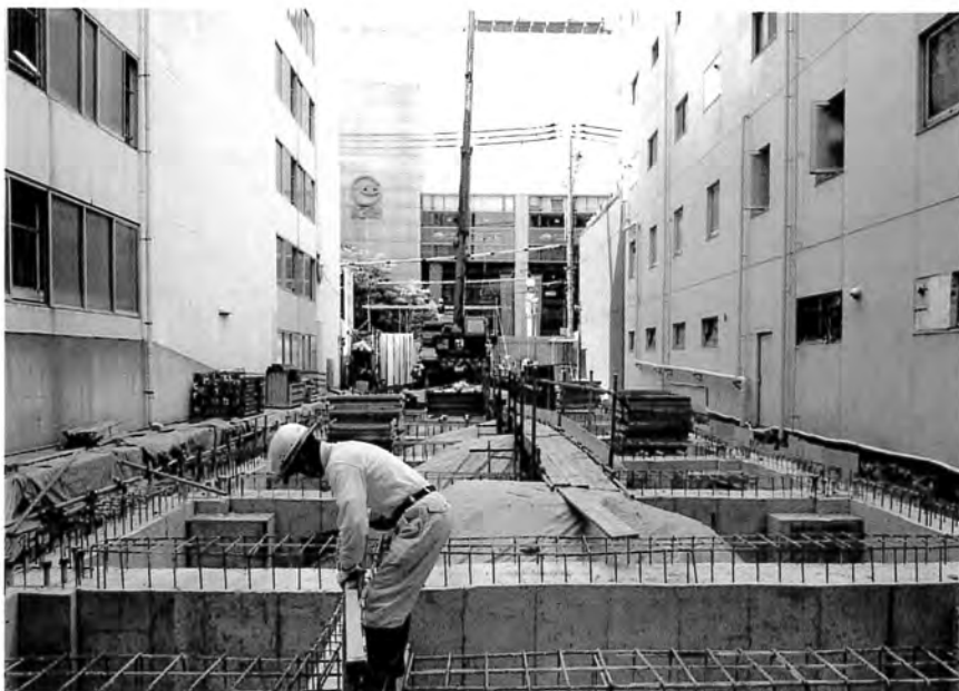
調査地より南を望む (手前が調査区)
