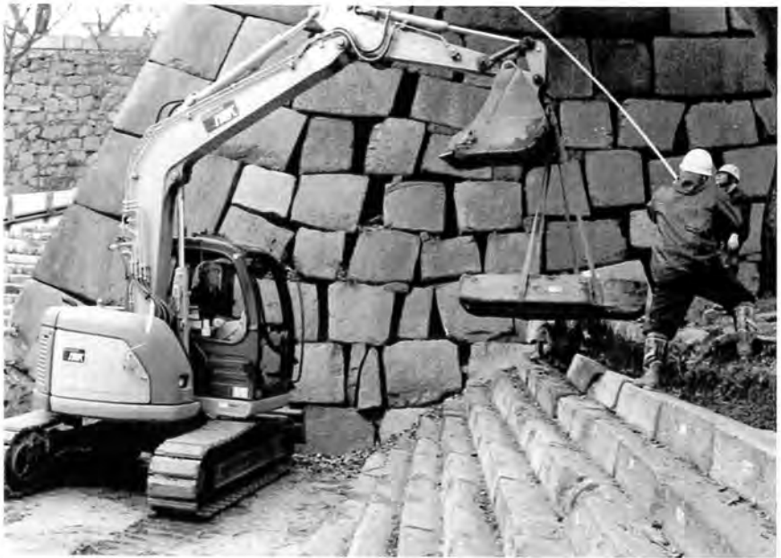
1区雁木石 取り外し作業 (北から)
