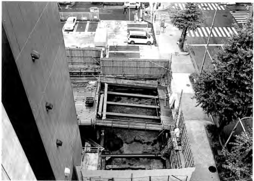
調査区全景(西から、 南は中央大通り)
