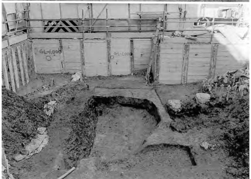
SK101掘削状況 (南から)
