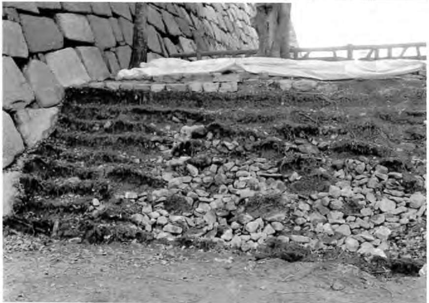
1区雁木石 取り外し後 (東から)
