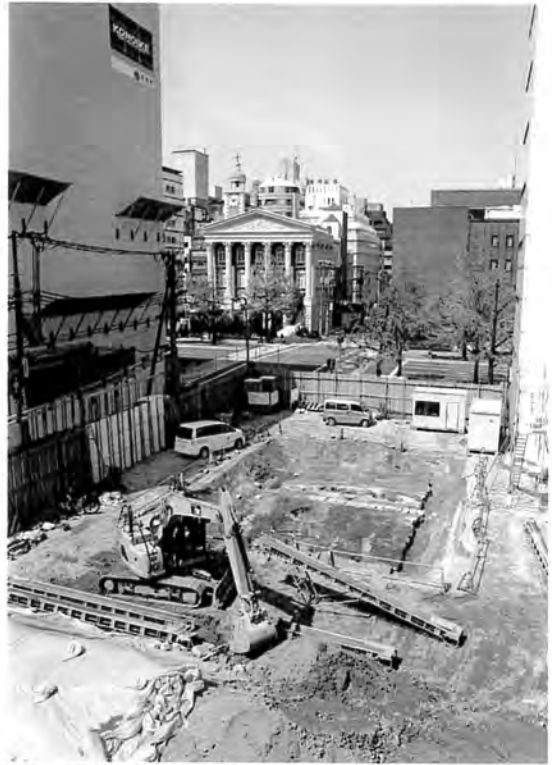
東から調査地・御堂筋・東本願寺難波別院を望む (東北東から)
