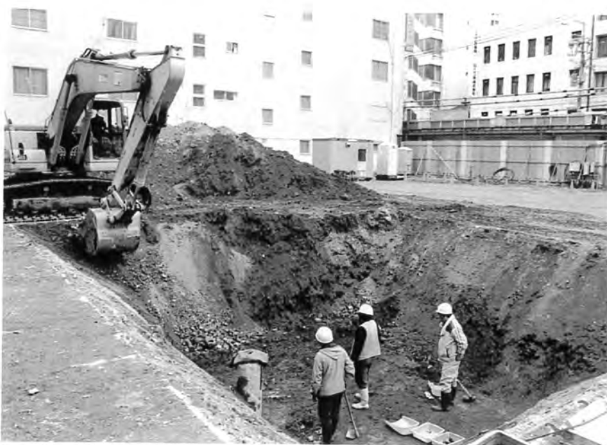
機械掘削状況 (北西から)
