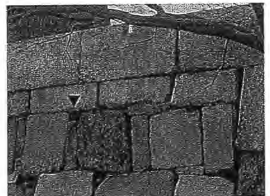
写真1 外廻りの石垣(切込みハギ) 雁木裏込めトレンチの正面(矢印は図版と対応)
