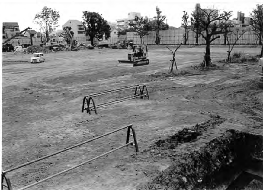
調査地近傍 (西から) 右手前がB区、左奥の バックホーのある場所 がA区
