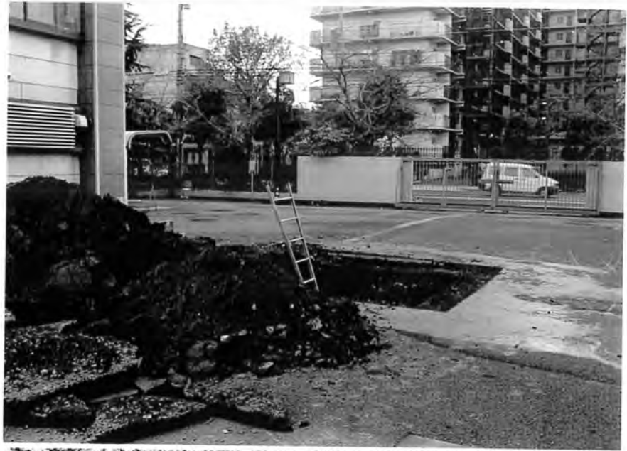
No.4 ピット (北から)
