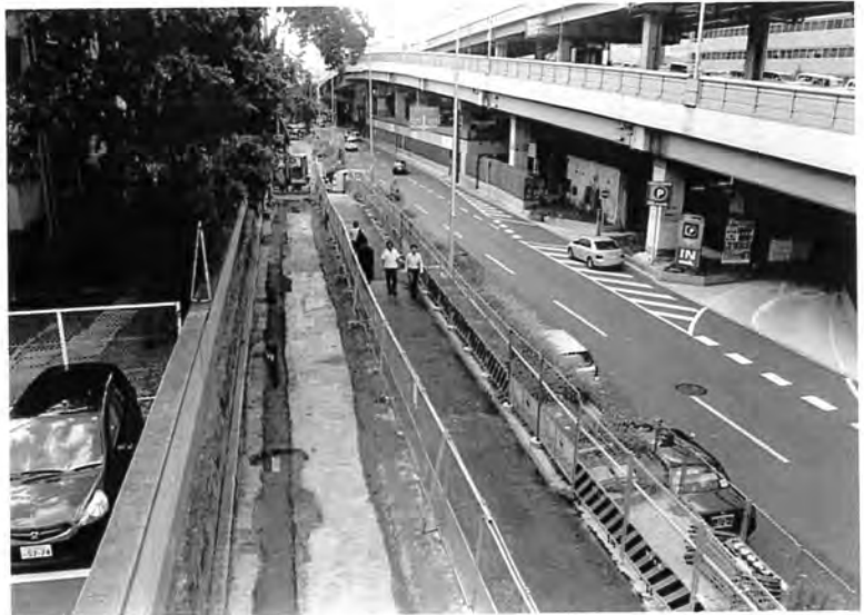
調査区と中央大通り (東より)
