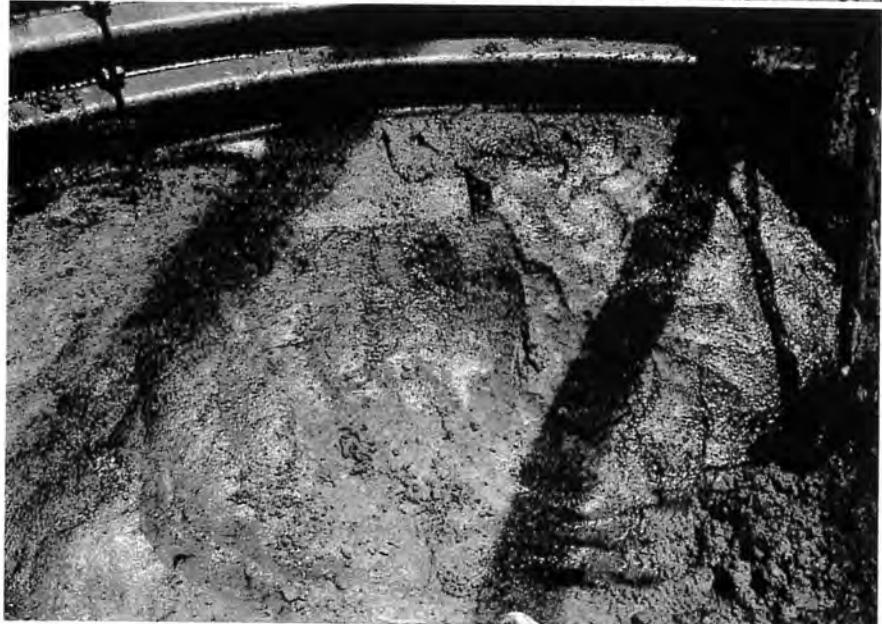
発進坑北壁の断面 地表下7 m付近 (南から)
