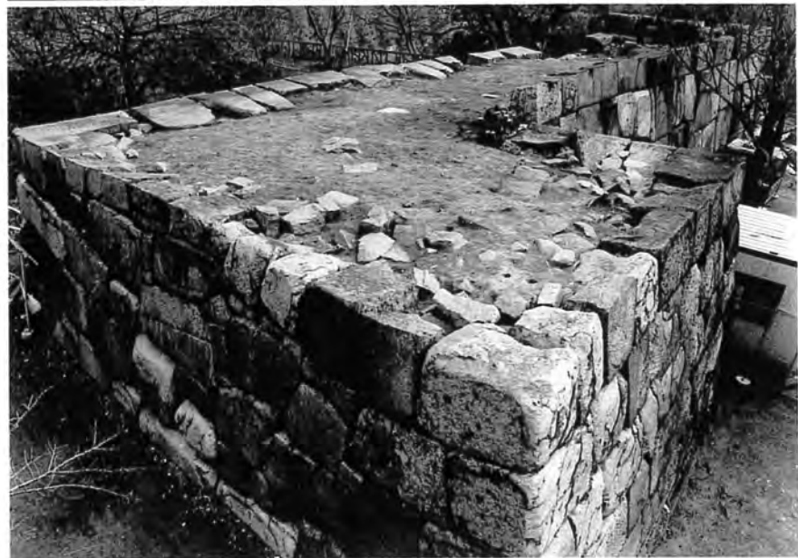
東区(北西から)
