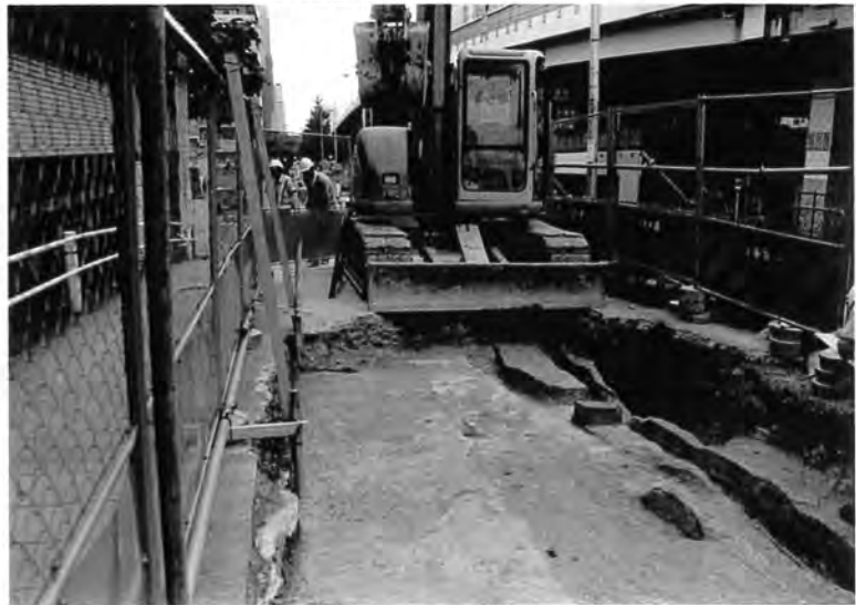
調査区西端 (東より)
