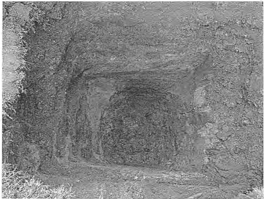
写真1 ④試掘トレンチ検出の井戸
