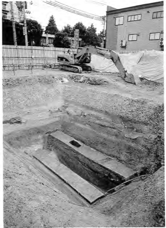
西区全景 (南西から)
