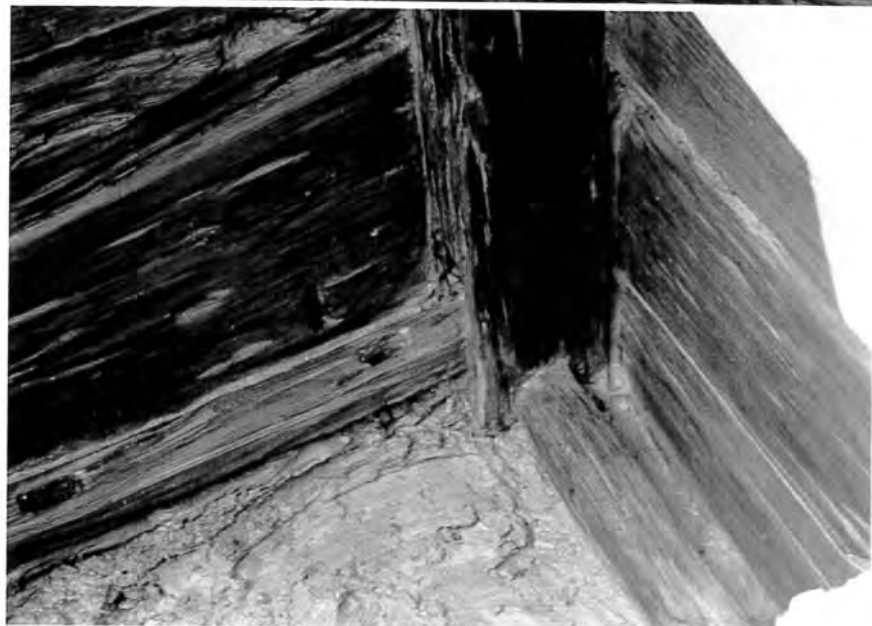
SE101北西隅木組み
