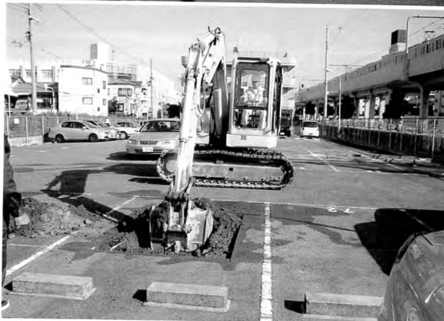
作業風景 (南から)
