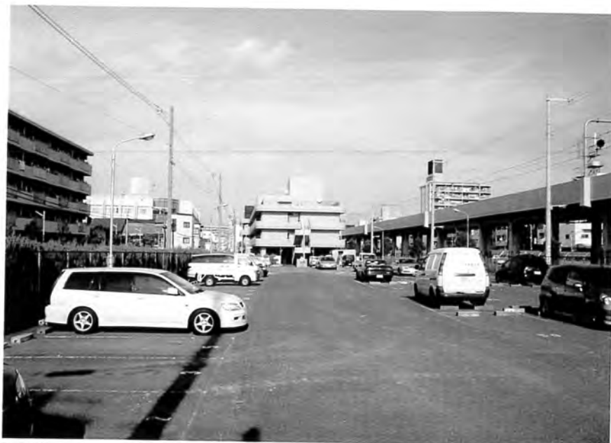
調査地全景 (南から)
