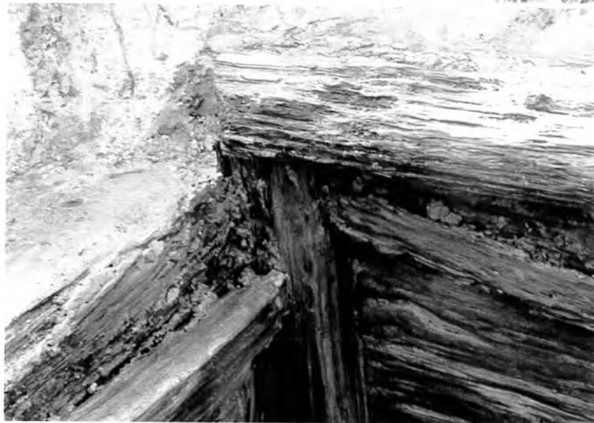
SE101南西隅木組み
