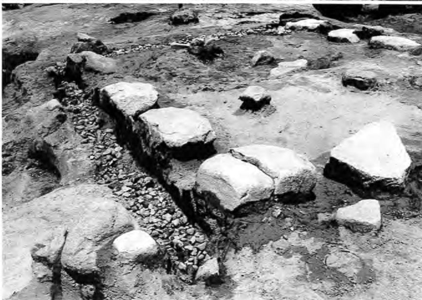
塙列建物南西角の施工状況
