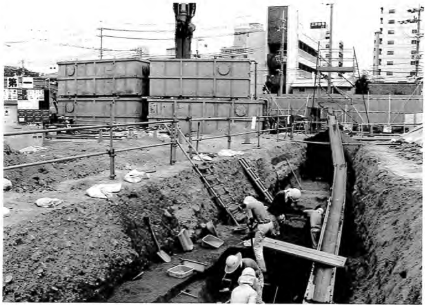
①現場作業風景 (南から)
