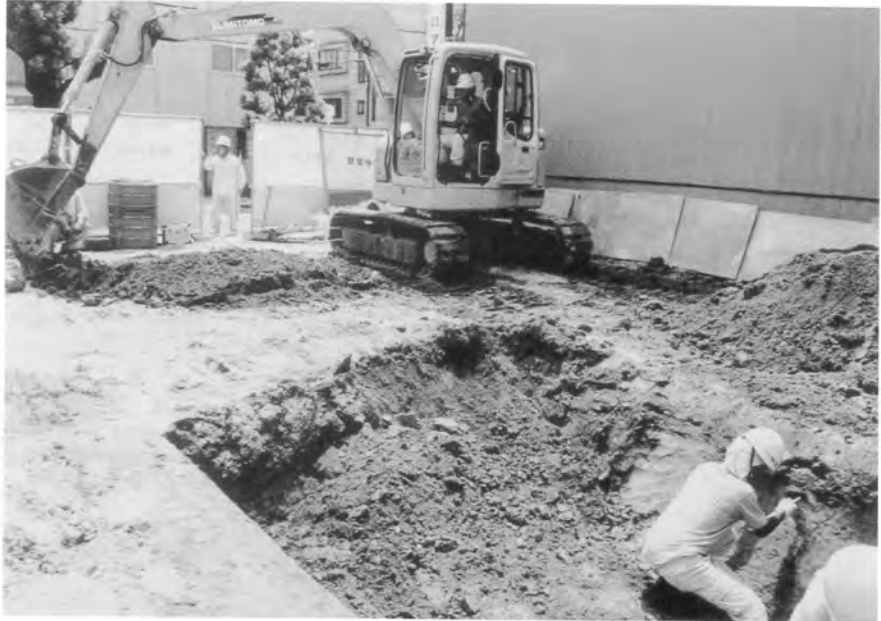
機械掘削状況 (北西から)
