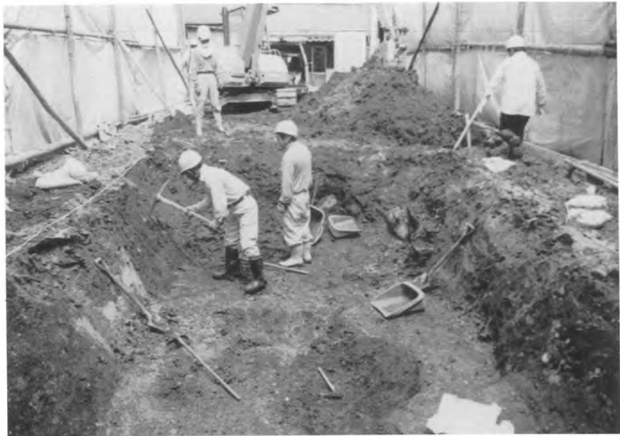
機械掘削状況 (南から)
