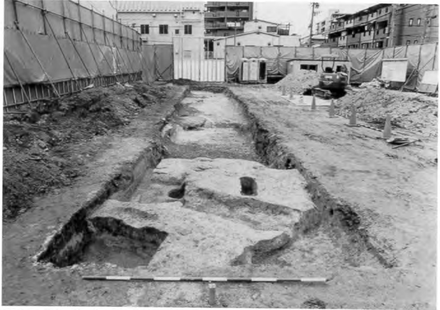
調査地全景 (南から)
