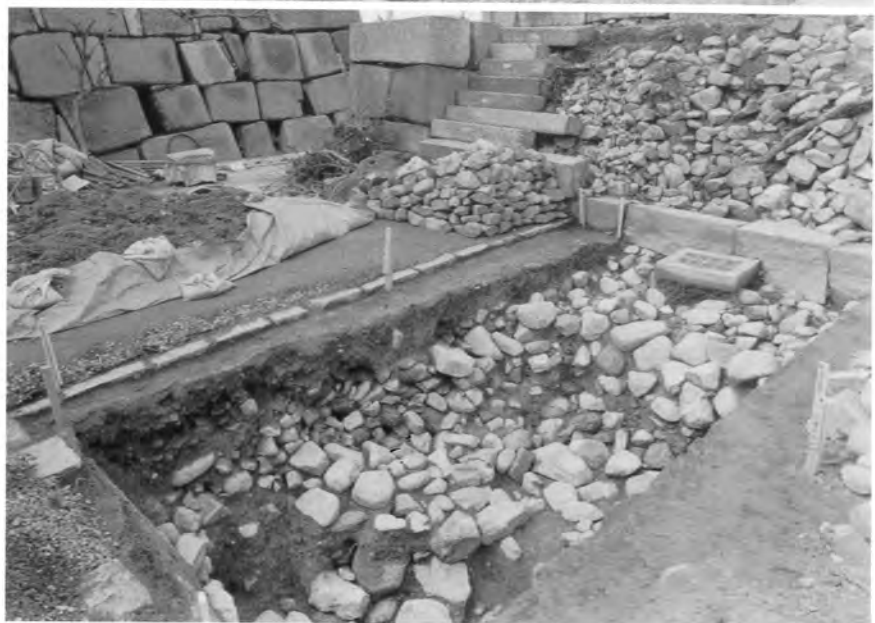
Ⅳ区石垣裏込検出状況 (北東から)
