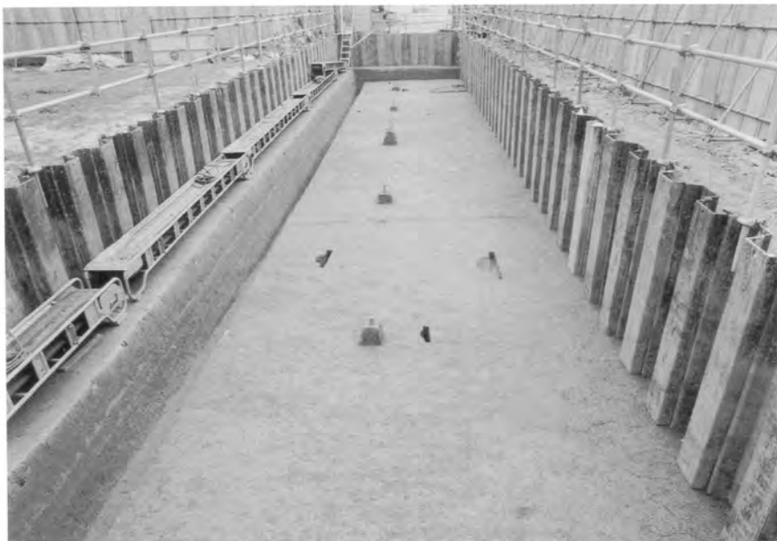
第7層上面検出遺構 (東から)
