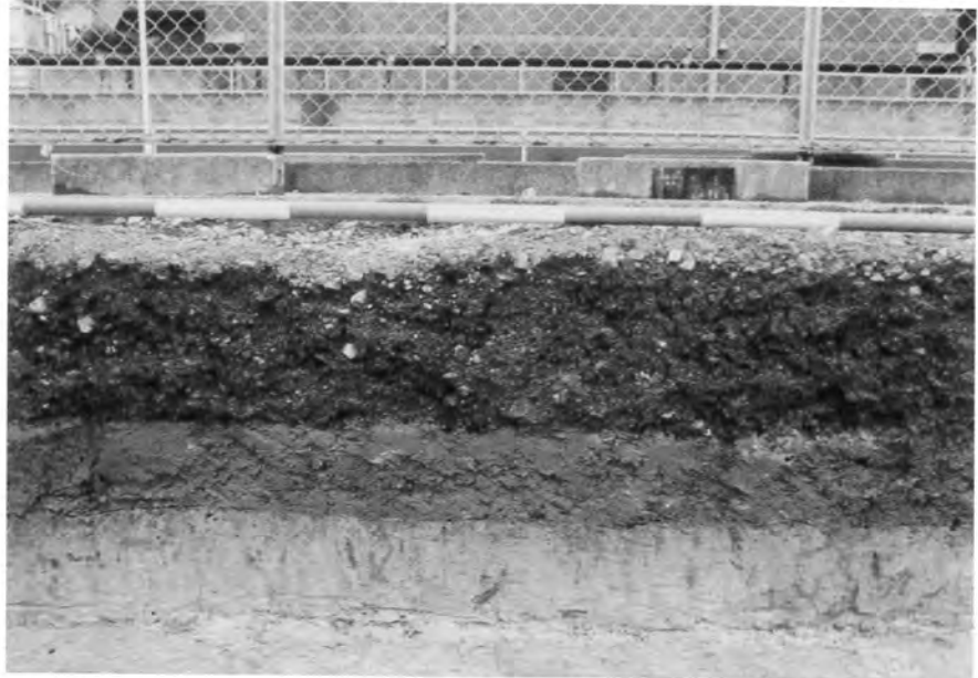
南壁断面 (北から)
