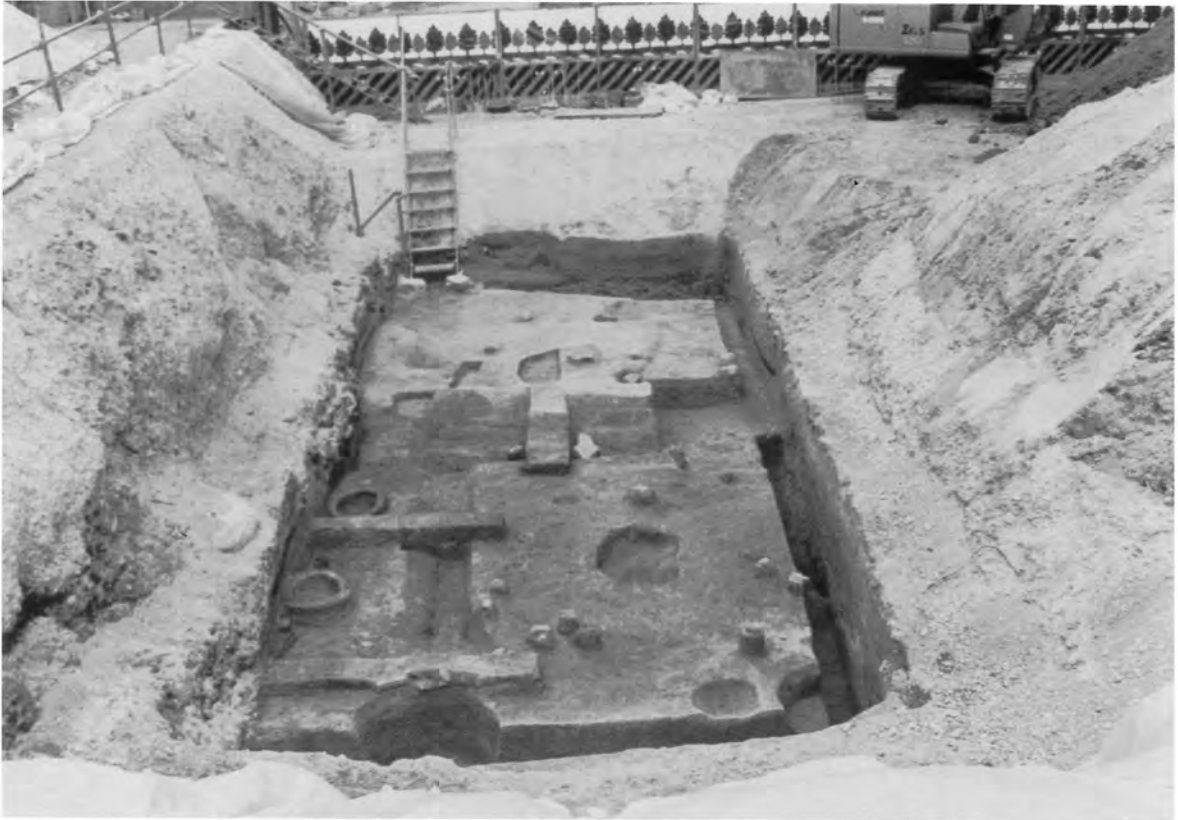
調査地全景(東から)
