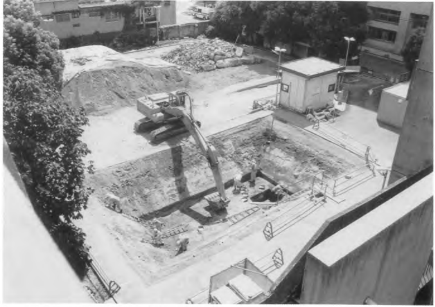
調査地全景 (北西から)
