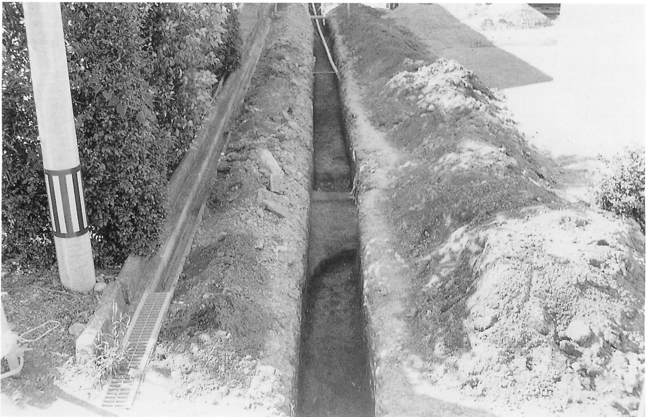
調査区全景（北から）
