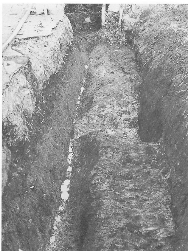
D区 (西から)
