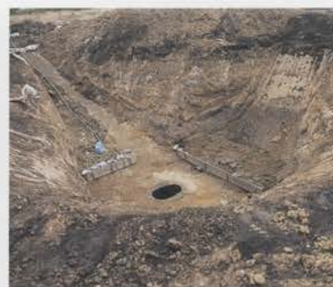
写真 61 SE03 標高 5,000 m 地点まで掘削
