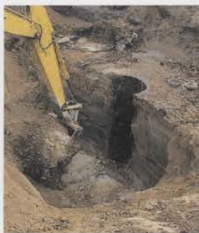
写真 63 SE03 標高 5,000 m 地点から下底まで重機による半裁
