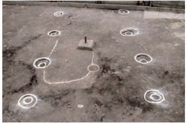
12 地区 SB01 東から
