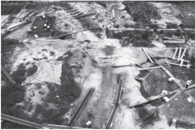
11・12 地区 つなぎ箇所 南から
