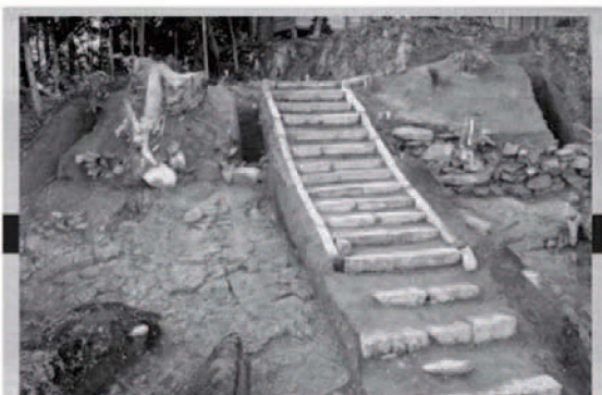
15 Ⅳ区1号平場1号石道 岩盤の上に直接石を積んでいる。
