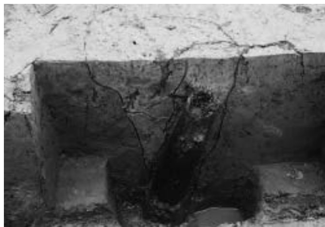
P086 セクション (東から)
