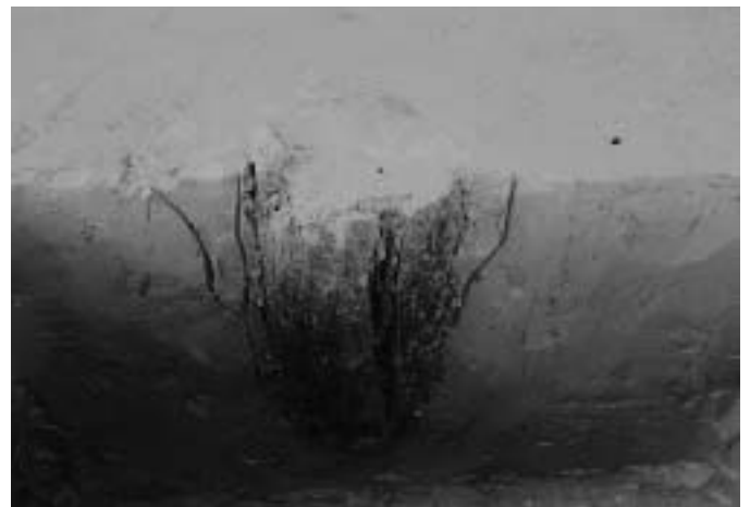
P479 セクション(東から)
