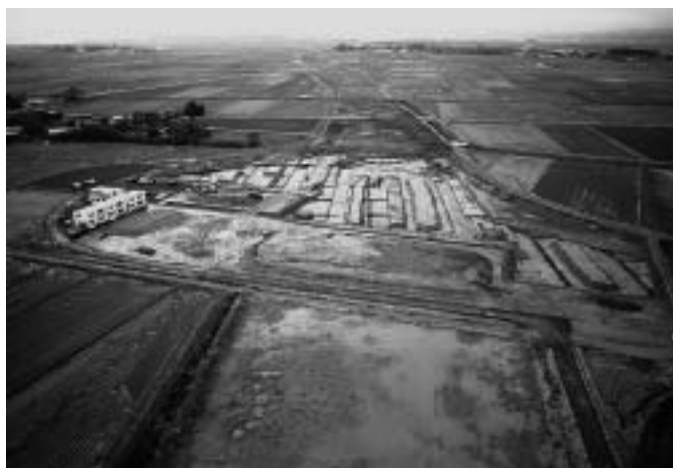
下層 調査区近景（南から）
