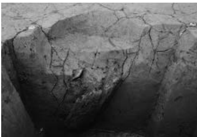
P014 セクション (東から)
