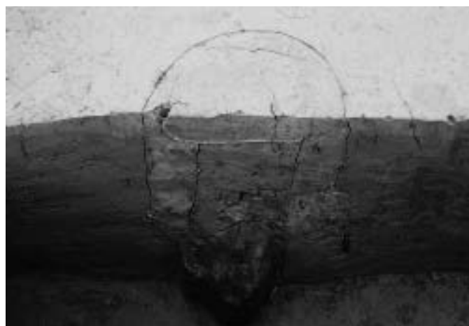
P471 セクション (東から)
