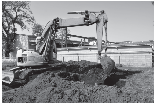
中東遺跡第 10 地点 埋め戻し
