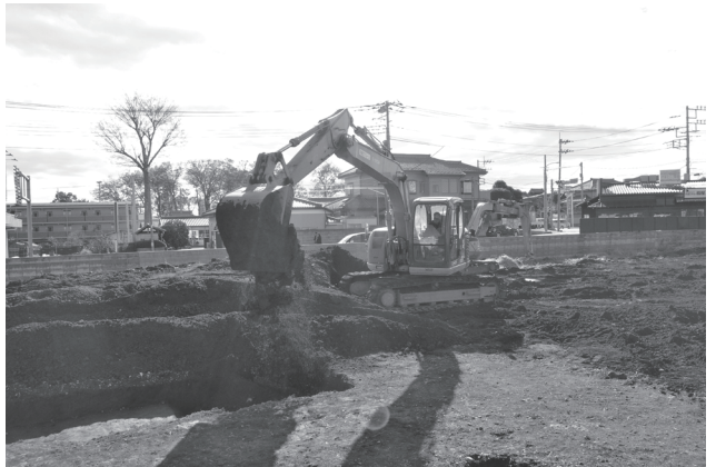
藤久保東遺跡第 28 地点 埋め戻し
