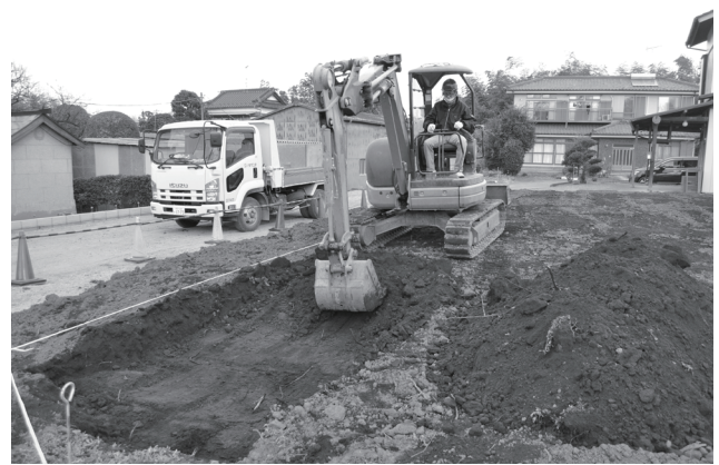
本村南遺跡第 13 地点 表土剥ぎ
