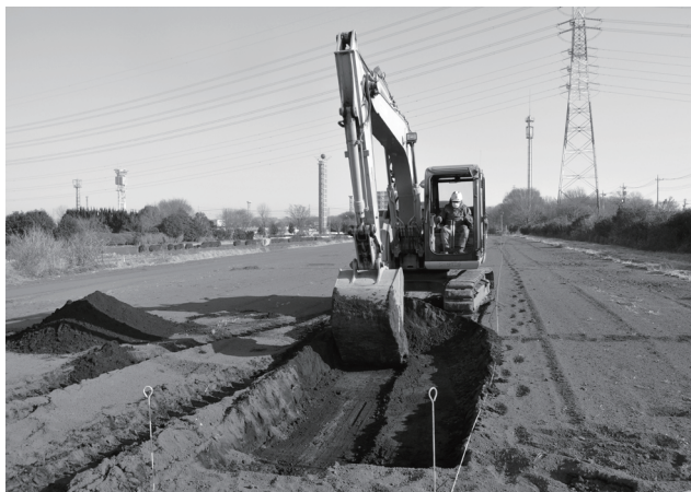
東永久保南遺跡第 1 地点 表土剥ぎ
