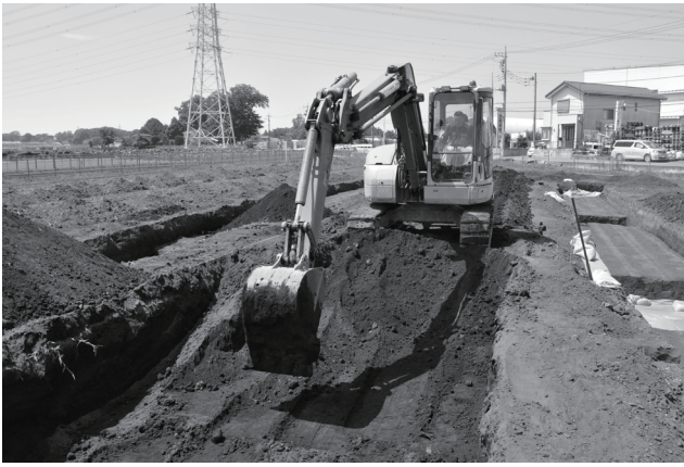
東永久保遺跡第 2 地点 (発掘) 表土剥ぎ
