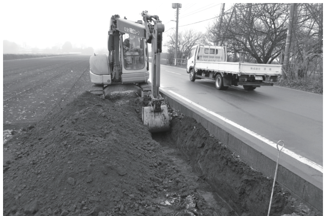
東永久保南遺跡（近接地） 表土剥ぎ
