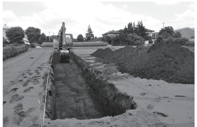
藤久保南遺跡第 2 地点 表土剥ぎ
