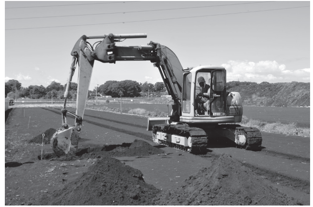
中東遺跡第 10 地点 表土剥ぎ
