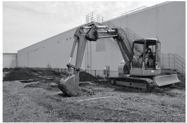
中東遺跡第 12 地点 表土剥ぎ
