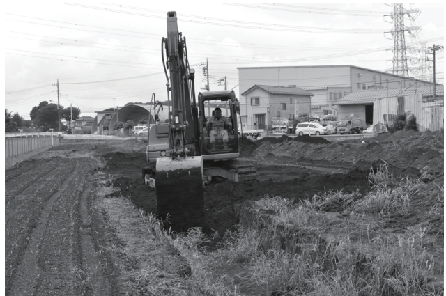
東永久保遺跡第 2 地点 (発掘) 埋め戻し
