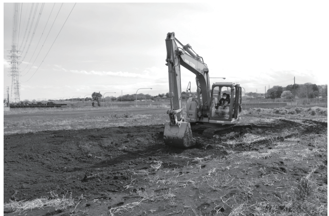
中東遺跡第 11 地点 埋め戻し
