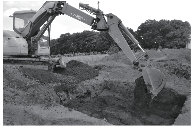
中東遺跡第 12 地点 埋め戻し
