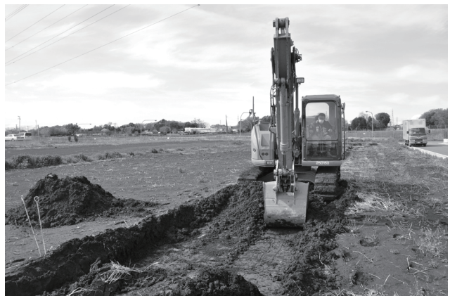
中東遺跡第 11 地点 表土剥ぎ
