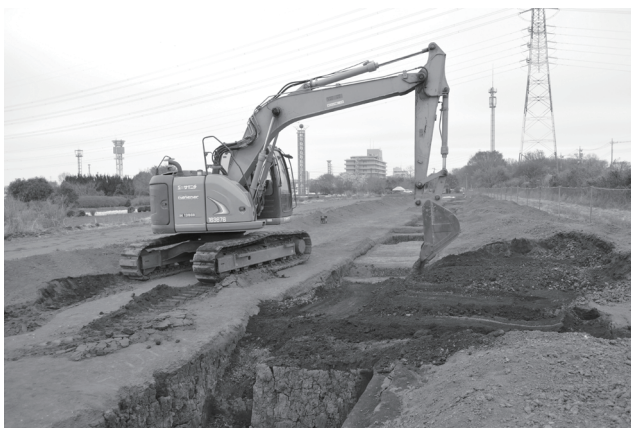
東永久保南遺跡第 1 地点 埋め戻し
