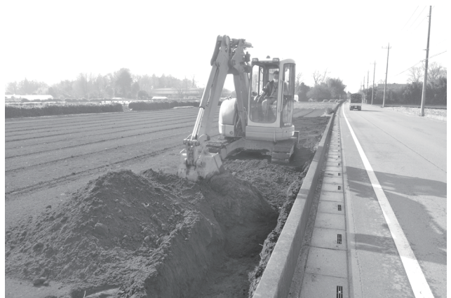
東永久保南遺跡（近接地） 埋め戻し
