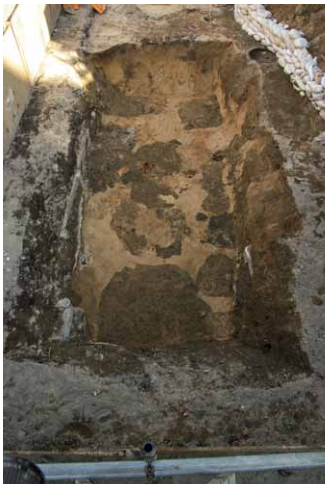
5. 攪乱001掘削状況（北西から）
