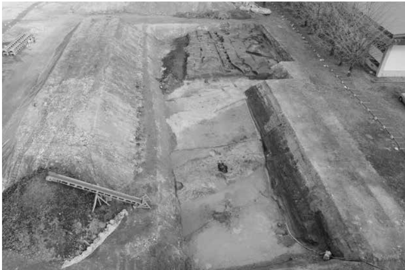
(2) II区全景（南西から）
