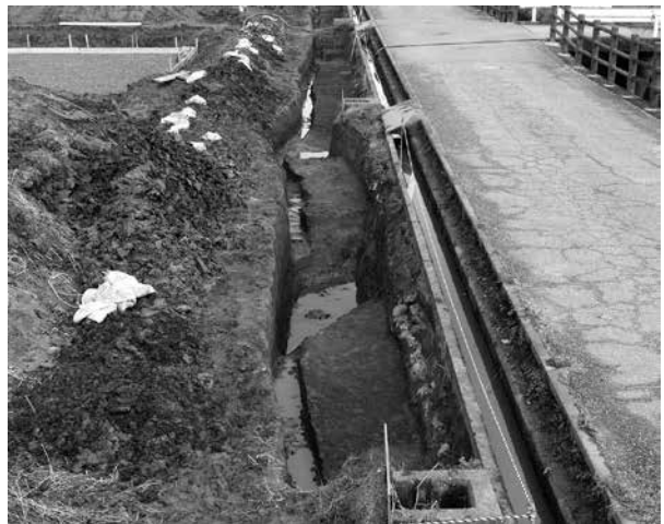
写真 2-5 第6トレンチ完掘全景（北から）
