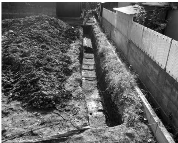
写真 11-1 東西方向完掘全景（東から）
