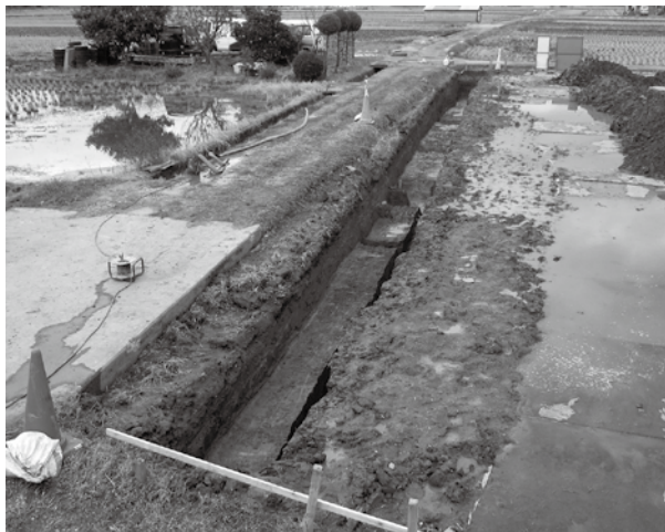
写真 20-1 第 1 トレンチ完掘全景 (南から)
