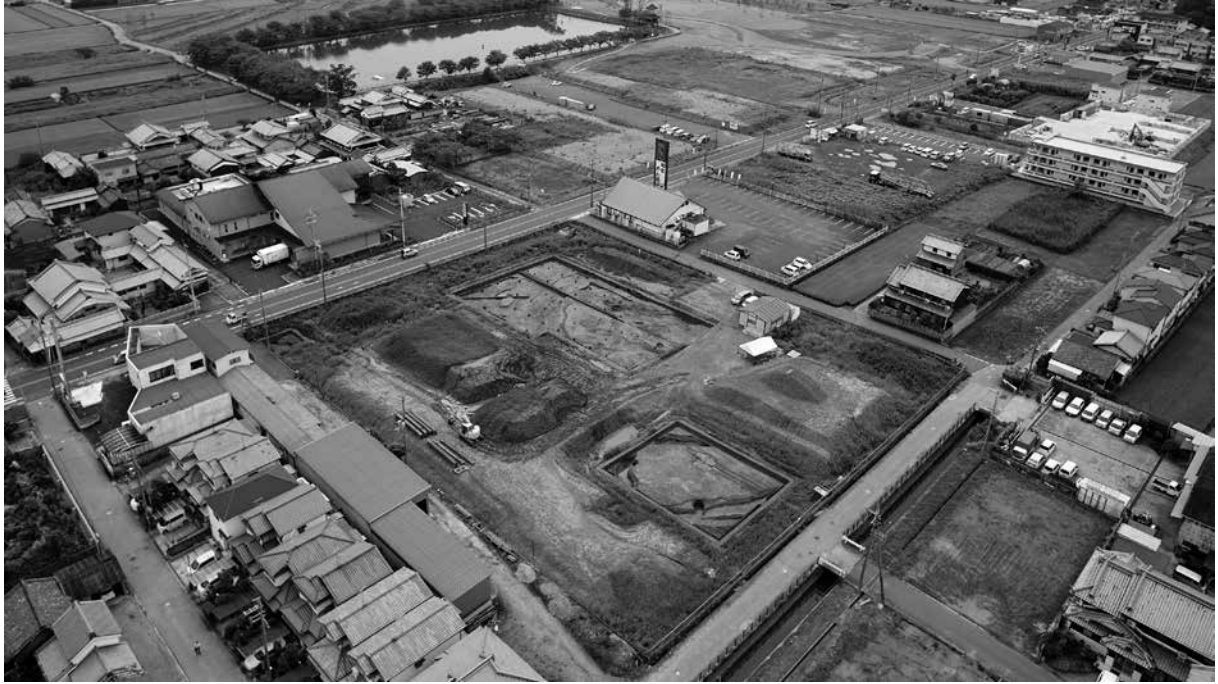
写真 2-1 調査地全景空撮（北西から）
