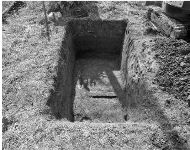
写真 8 完掘全景（北から）
