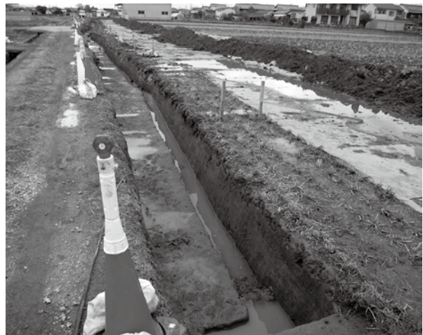
写真 20-2 第 3 トレンチ完掘全景 (南から)
