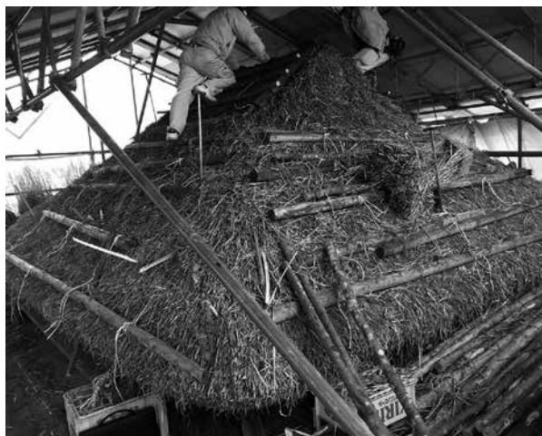
【最上層の修理】
