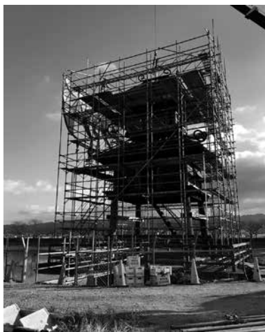
【修理中の復元楼閣】
