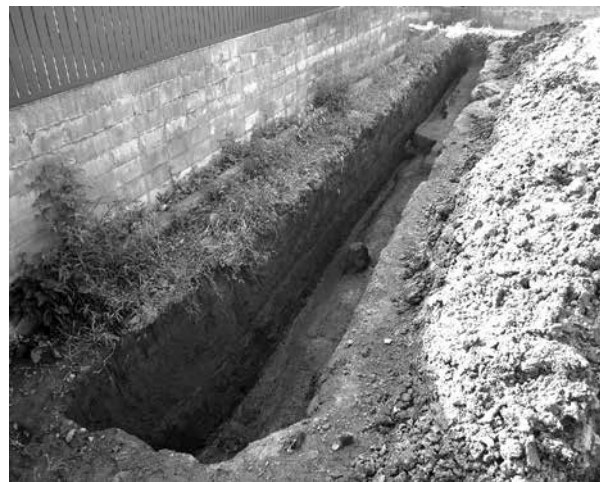
写真 11-2 南北方向完掘全景（南東から）
