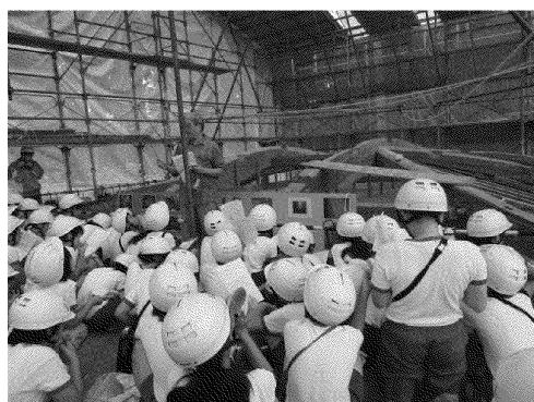
龍潭寺御霊屋修理見学会の様子
