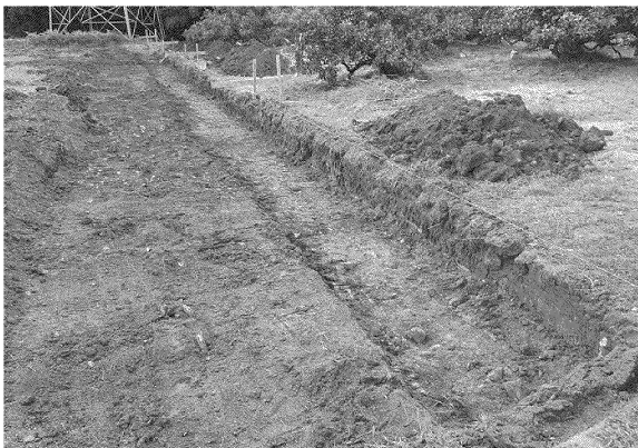
B2工区全景 (北から)
