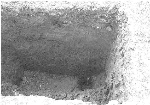
立会箇所調査状況
