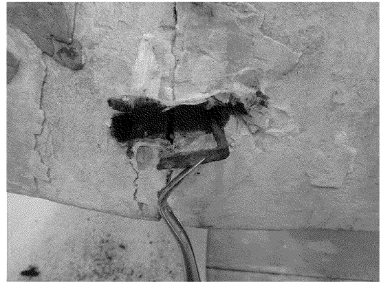
持国尊天 腐食銹（かすがい）の除去
