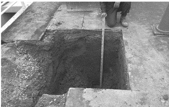
調査坑完掘状況
