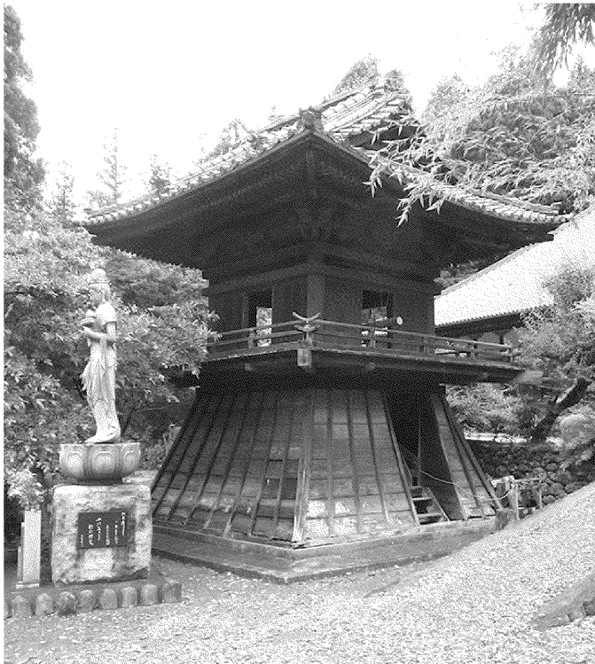
修理前 (全景南東面)
