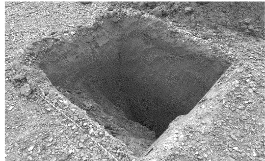
調査坑1完掘状況
