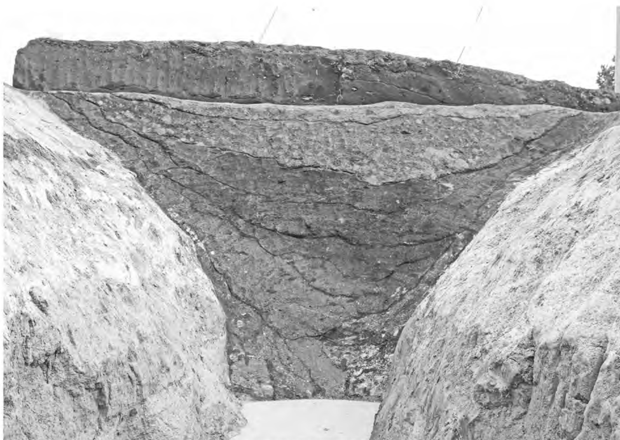
第1号堀跡 断面 C-C' (南西から)
