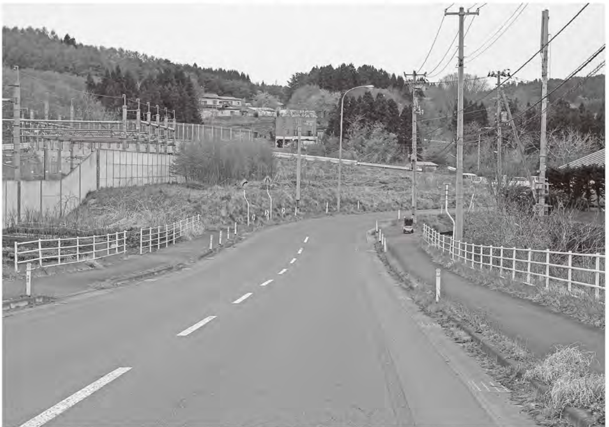
調査区近景（北から）
