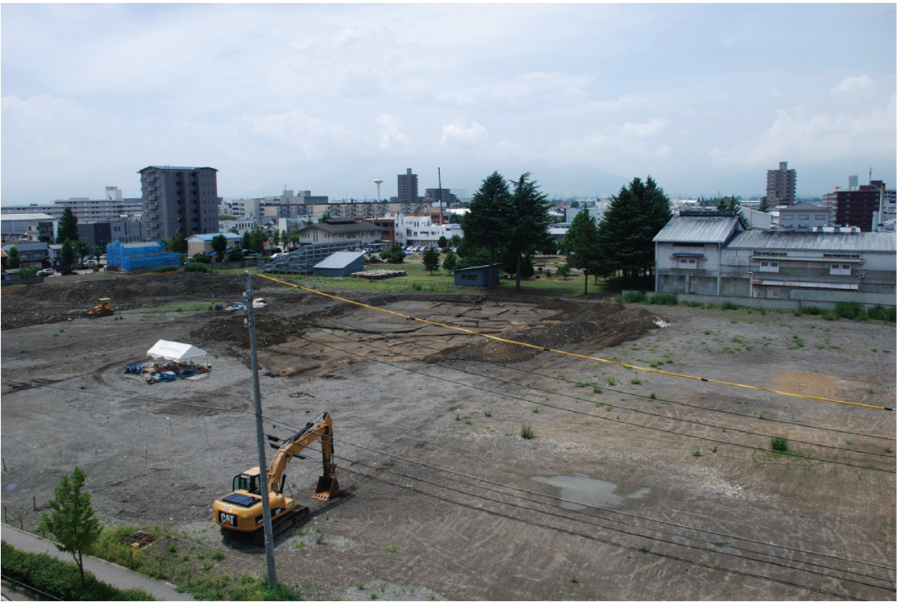
出川西遺跡第 10 次調査 調査地遠景（北東から写す）
