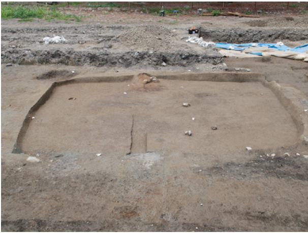
19住 掘削状況（東から）
