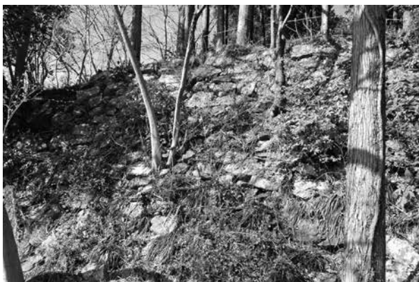
Fig.30 西の丸I城内で最も高い石垣
