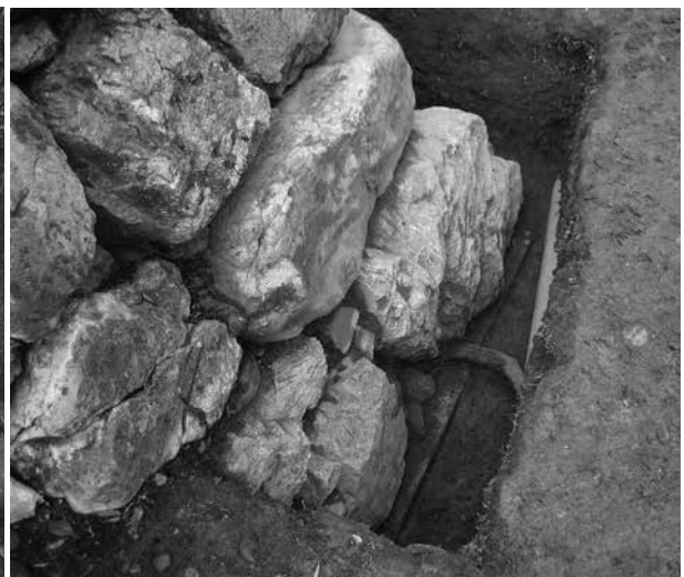
Fig.49 北西隅角調査状況
