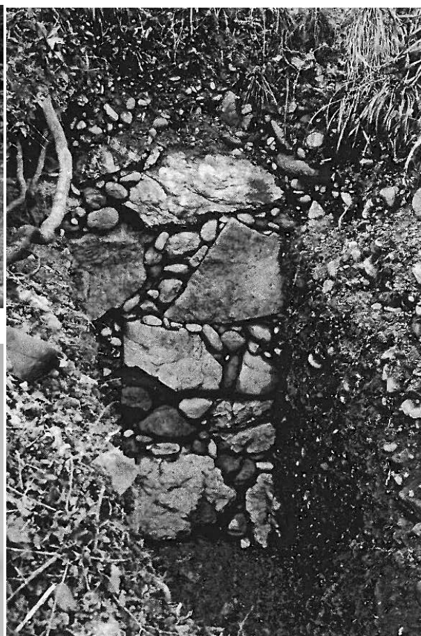
Fig.52 大手道石垣埋没状況
