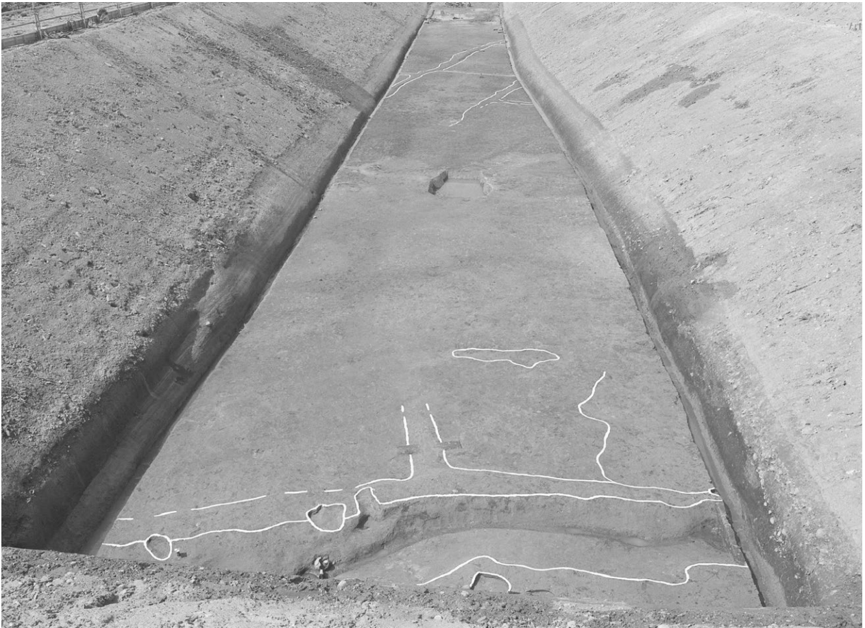
1. 調査区東半部 第7面 全景 (東から)
