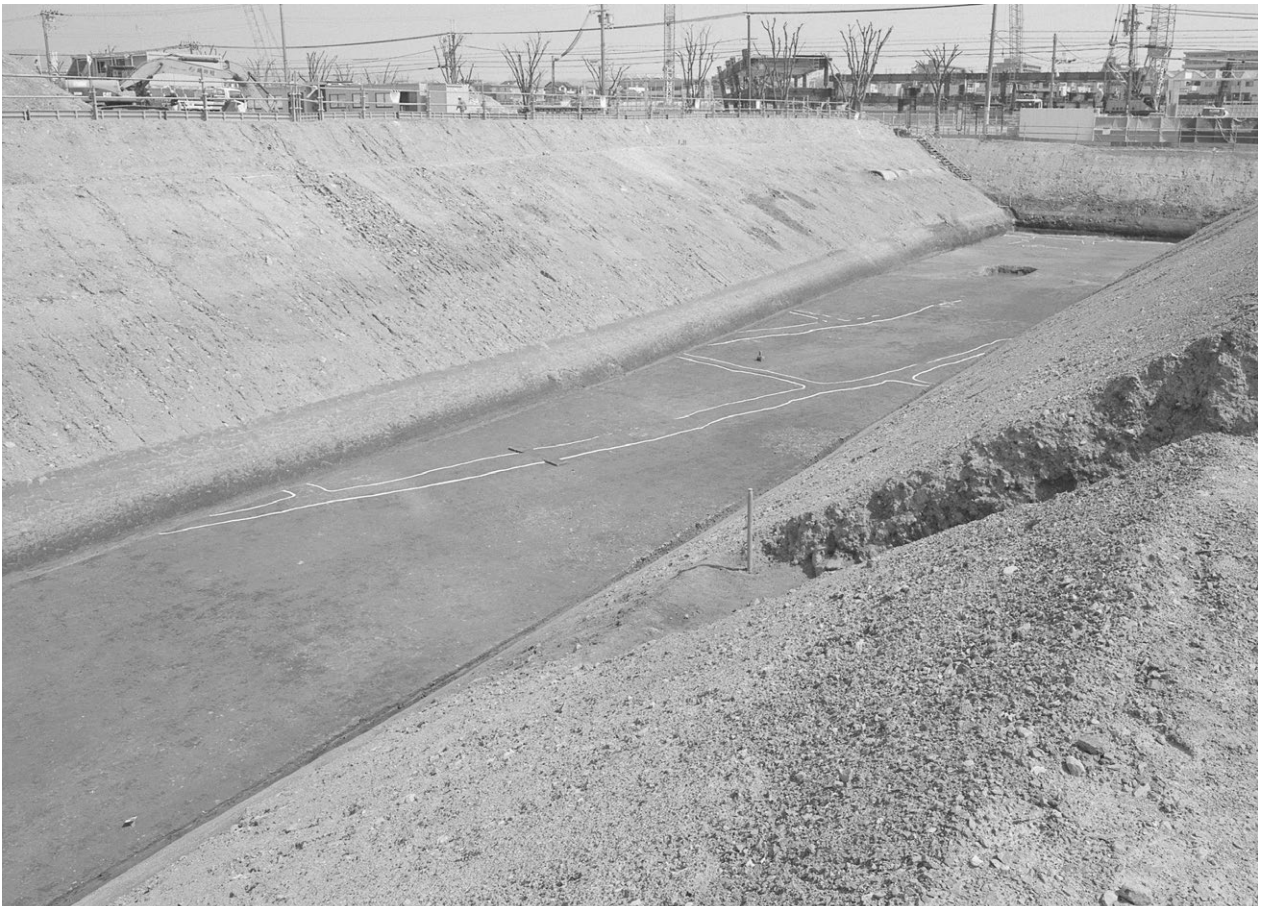
2. 調査区東半部 第7面 全景 (南西から)
