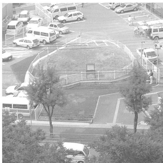
写真7 工事後の全景(平成16年6月撮影,南から)
