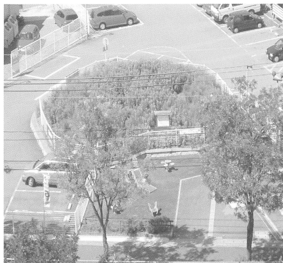
写真6 工事前の全景(平成15年8月撮影,南から)
