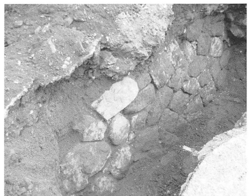
写真9 1区石垣西端部分 (北東から)
