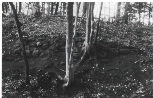
B区 石積01遠景
