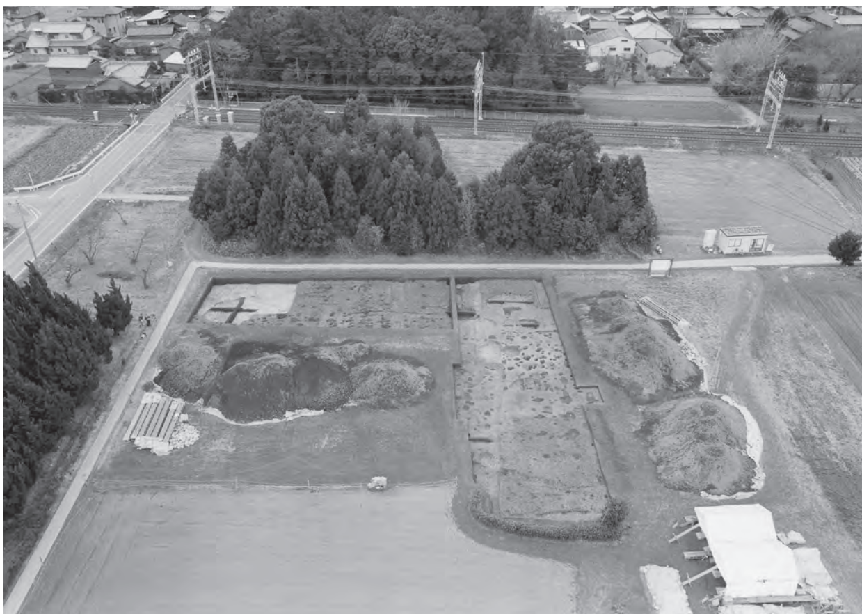
第 153 次調査区全景（北から）
