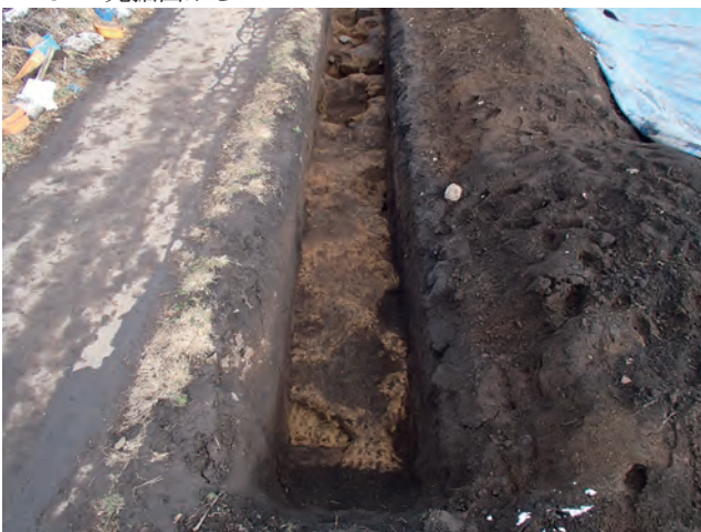
B1T 西側 完掘西から
