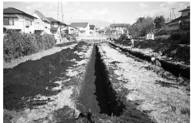
6. 17 高山古墳群 2 地区 6・5・4Tr (南から)
