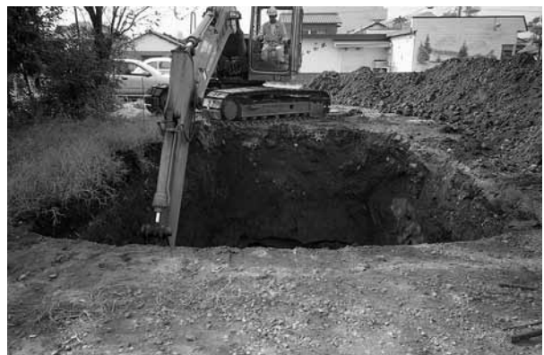
7. 08 沖田遺跡120次 掘削状況
