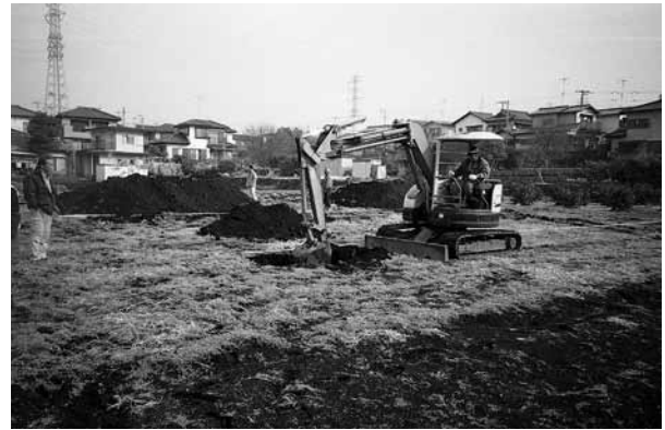
3. 16 舟久保遺跡 45 地区 掘削状況
