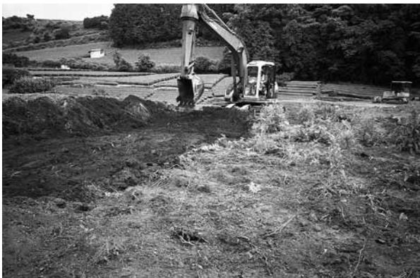
4. 03 船津 7 古墳群 7 地区 掘削状況
