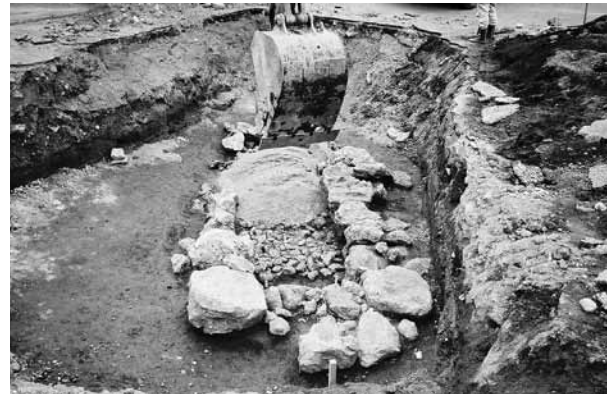
青砂による埋め戻し状況
