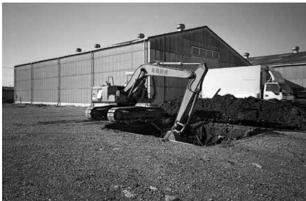
5. 13 沖田遺跡 122 次 掘削状況
