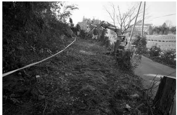
7. 14 比奈 1 古墳群 3 地区 調査風景 (北から)
