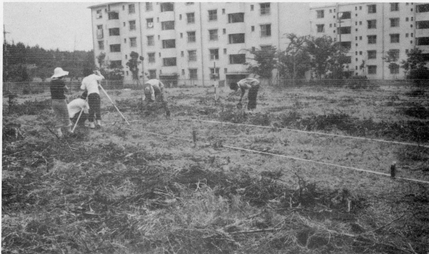
測量, トレンチ設定作業
