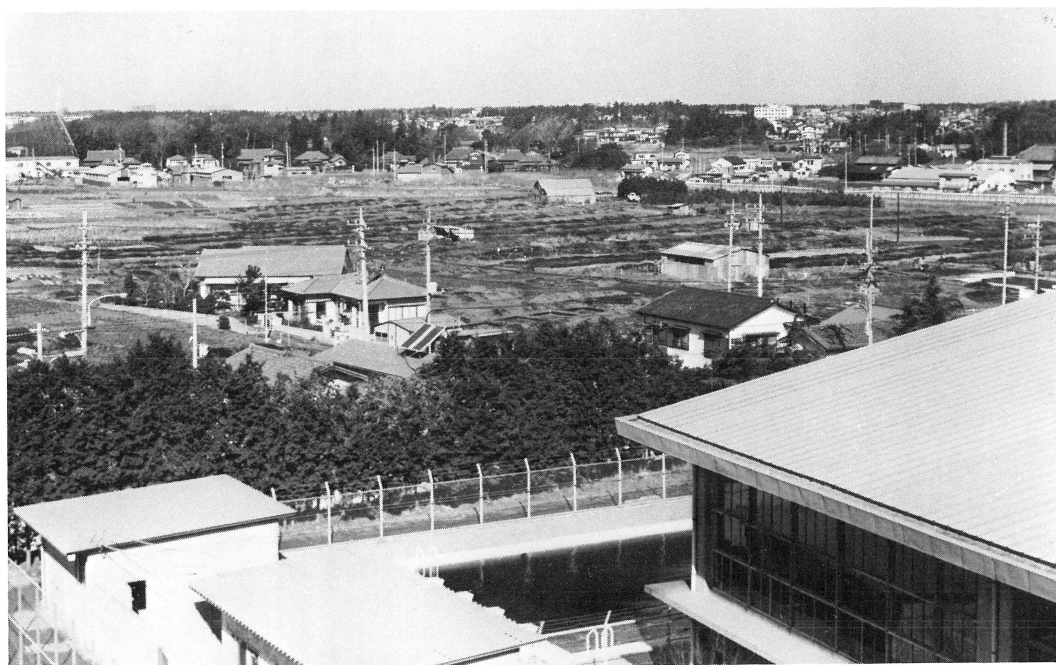
遺跡遠景（東側・八千代中学校屋上より）
