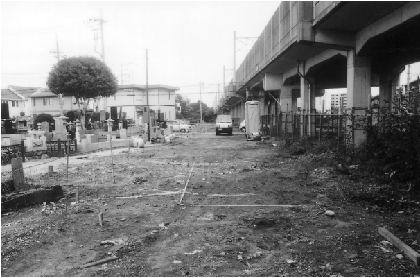
(1) 調査前状況 (西から)
