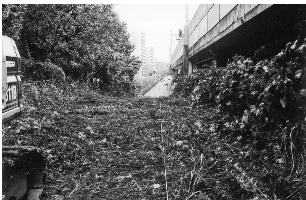
(1) 調査前状況(西から)
