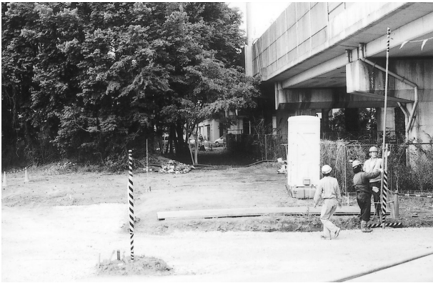
(1) 調査前状況 (西から)
