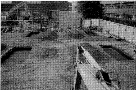
1. 調査区北東側掘削状況
