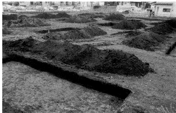
6. トレンチ掘削状況
